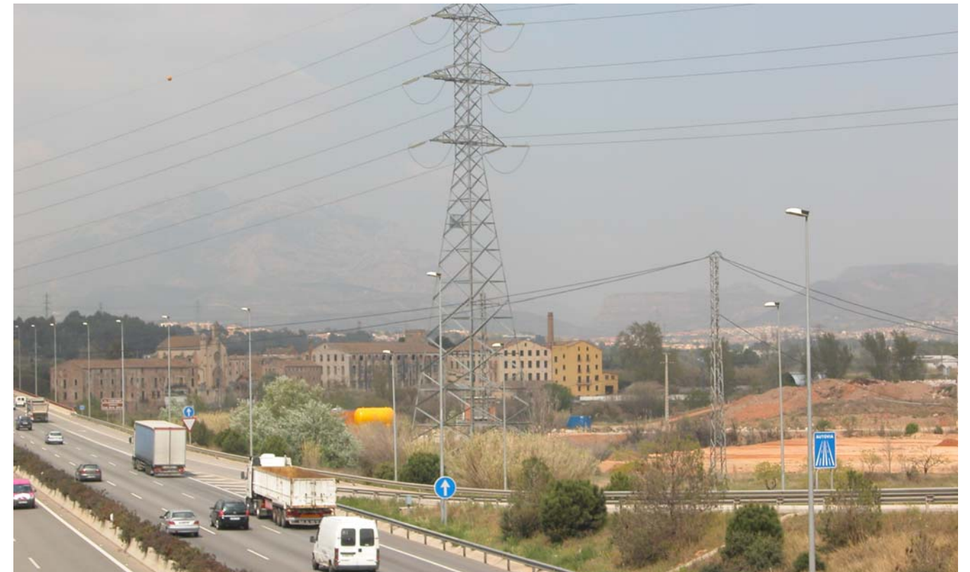
Figura 9.3: El pas de les grans infraestructures de transport és un element cabdal que caracteritza la unitat de paisatge. A la fotografia, l'A-2 i la colònia industrial de Can Bros, a les proximitats de Martorell.
