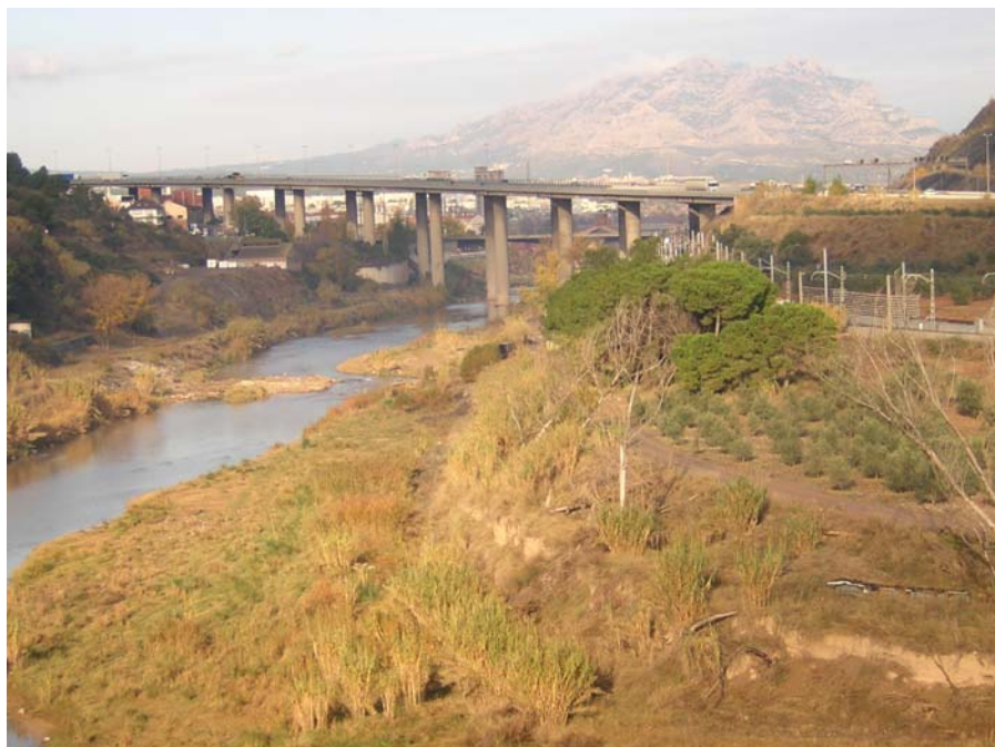
Figura 9.7: El Llobregat al congost del Cairat. Aquest congost és un lloc de pas estratègic com demostra la superposició d'infraestructures de diferents èpoques (des del pont del Diable, d'origen romà, fins als ponts recents).
