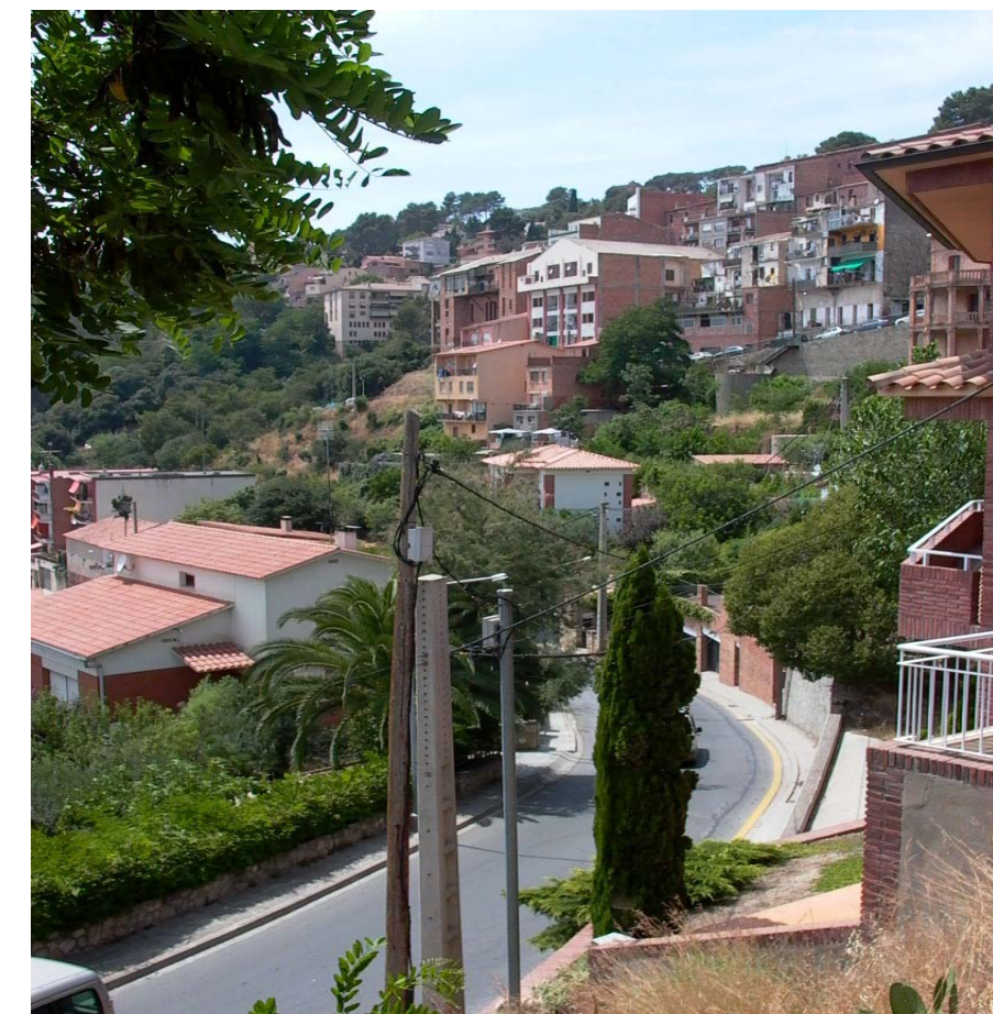
Figura 6.21: La construcció d'urbanitzacions a zones amb molt de pendent requereix sovint l'estabilització dels vessants.
