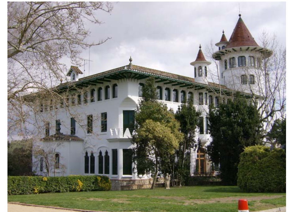
Figura 4.15: Les Caves Codorniu, edifici representatiu del modernisme català, impulsat per Manuel Raventós i Domènech, és obra de l'arquitecte Josep Puig i Cadafalch.
