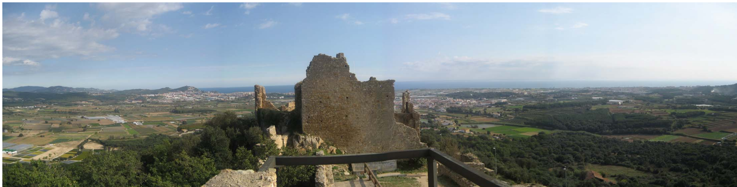
Figura 24.2: El Castell de Palafoxs, actualment enrunat, ofereix una de les millors panoràmiques d'aquesta unitat.
