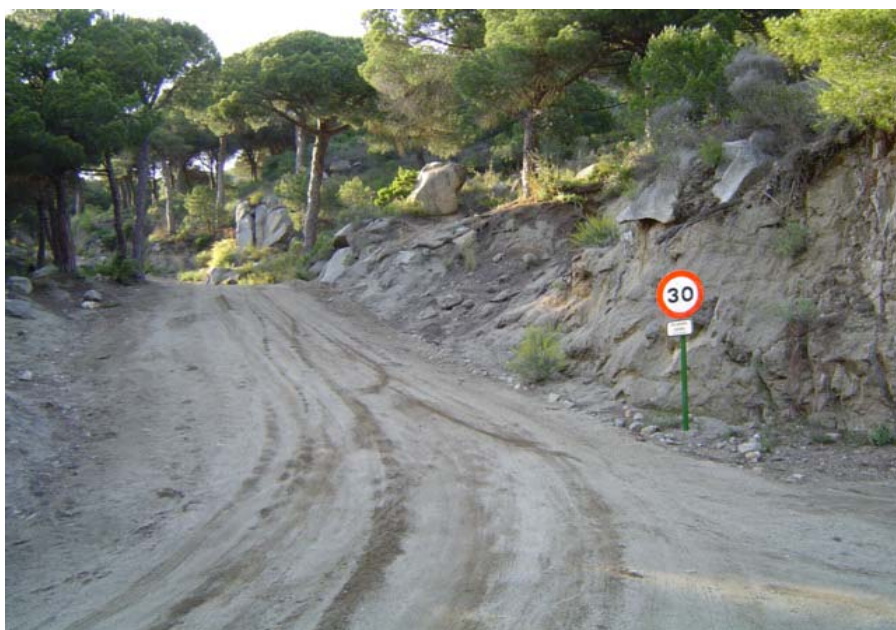
Figura 20.9: Els camins que solquen la Serralada de Marina es caracteritzen pel seu caràcter saulonenc i els problemes d'erosió.
