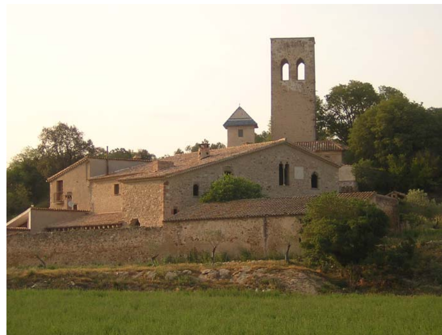
Figura 17.9: Palaudàries (Lliçà d'Amunt) és un dels nombrosos petits llogarrets de la plana vallesana que estructurava una comunitat rural dispersa i que havia gaudit de la consideració de parròquia pròpia durant segles, consideració que amb el pas del temps va perdre. Avui dia l'indret de l'església, que articulava la parròquia, és una mena de clap agroforestal rodejat d'urbanitzacions modernes.
