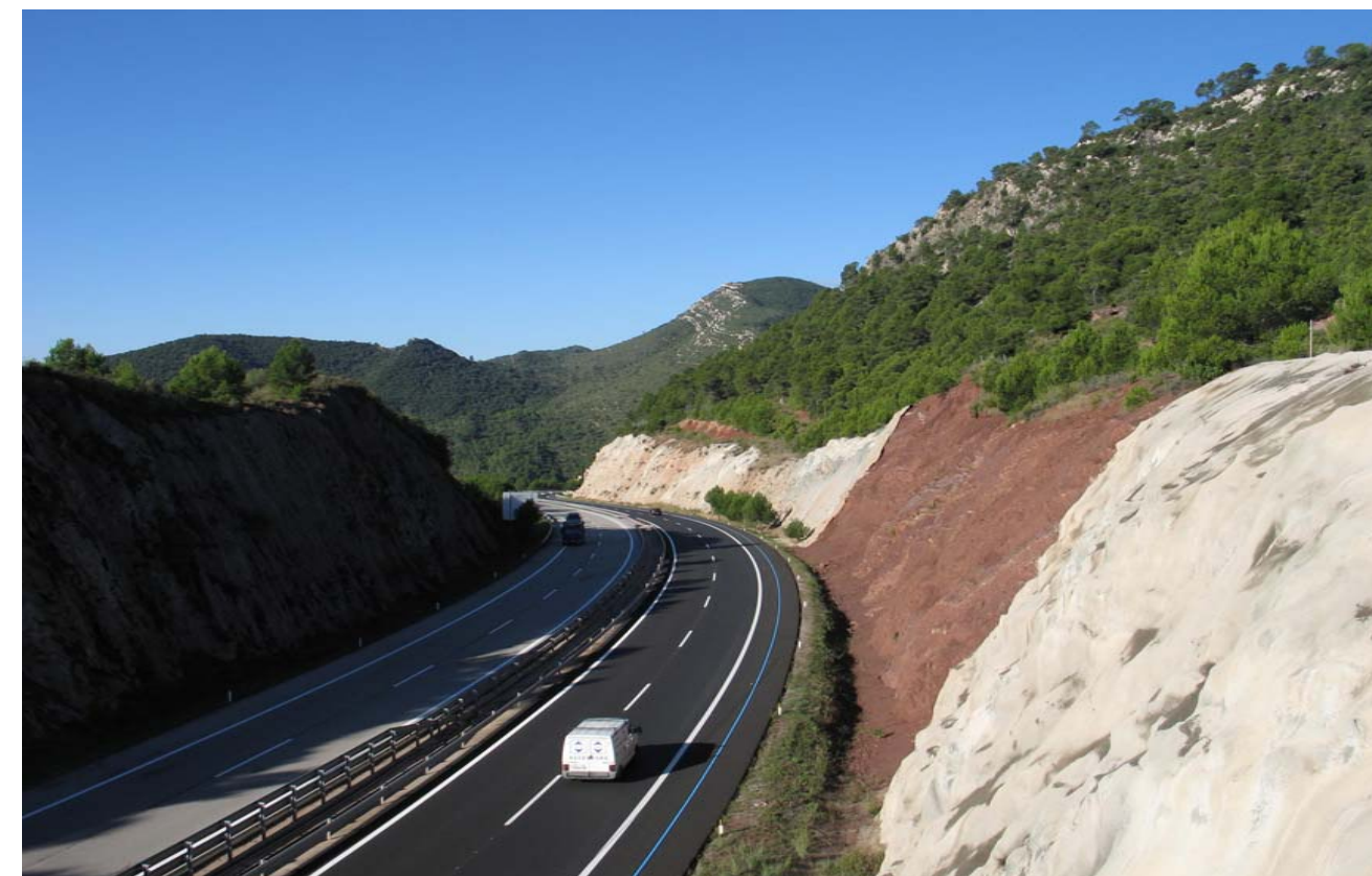
Figura 16.3: L'autopista C-16 al seu pas per Viladecavalls.
