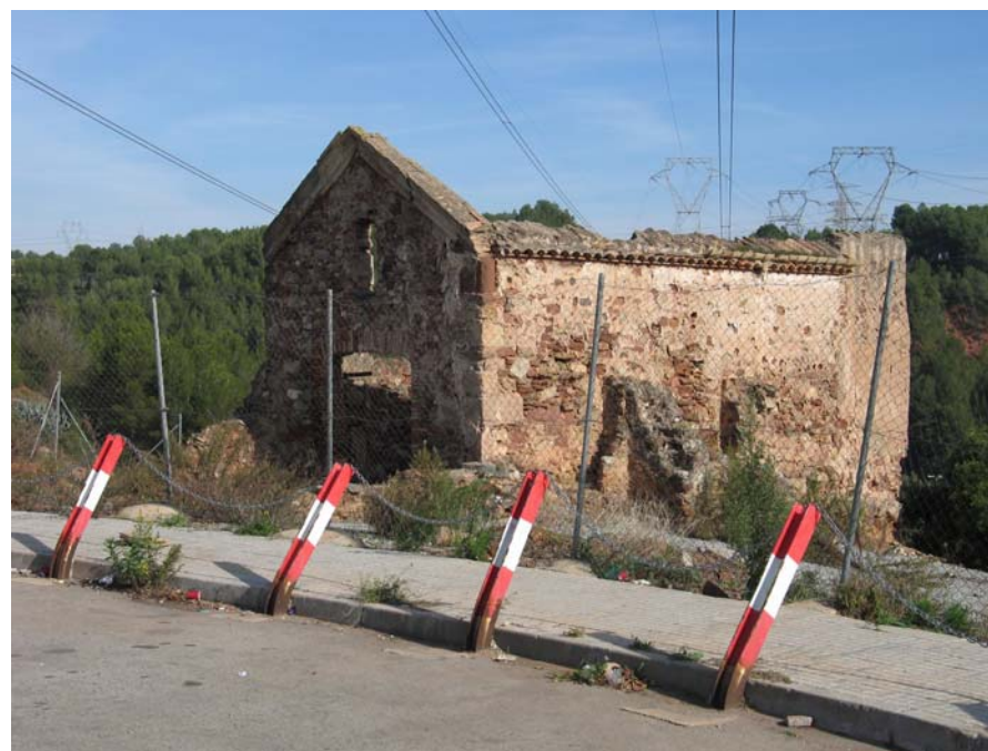
Figura 16.16: La degradació del paisatge s'incrementa amb la implantació d'infraestructures i usos que no tenen en compte les preexistències. En aquest exemple, les ruïnes d'un antic mas a Rubí han passat desapercebudes als nous elements d'urbanització.
