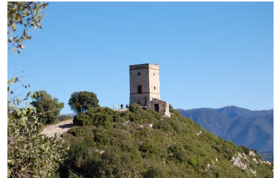
Figura 14.13: La torre de l'antic telègraf òptic ubicada al costat del santuari de la Mare de Déu de Puiggraciós.
