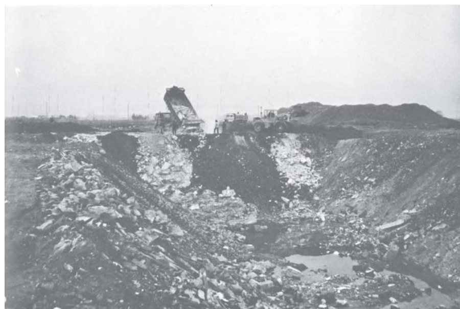
Figura 11.24: Bona part de les actuals ferralleries, deixalleries i desguassos dels voltants de la carretera de València (Gavà i Viladecans) provenen d'antigues graveres que van ser reblertes d'escombraries i runes. Ara que finalment es planteja la reconversió d'aquests usos, convé tenir en compte que els sòls hi estan molt malmesos. Fotografia d'abril de 1982 corresponent al municipi de Gavà. Font: Nova Tècnica Agro-Alimentària (1986: 91).
