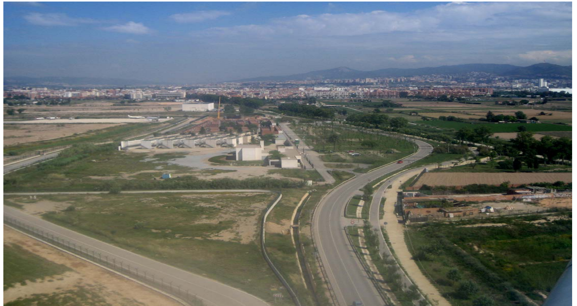
Figura 11.21: La carretera perimetral de l'aeroport del Prat, amb el Prat en l'horitzó.
