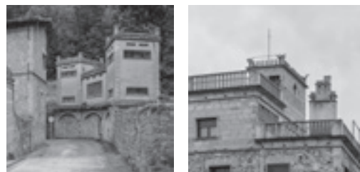
TRANSFORMADOR DE CAN PORXAS BARRET DE XEMENEIA
