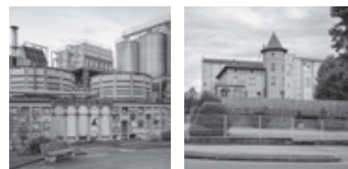
CEMENTIRI DE SANT JOAN LES FONTS TORRE DE CAN GOU
