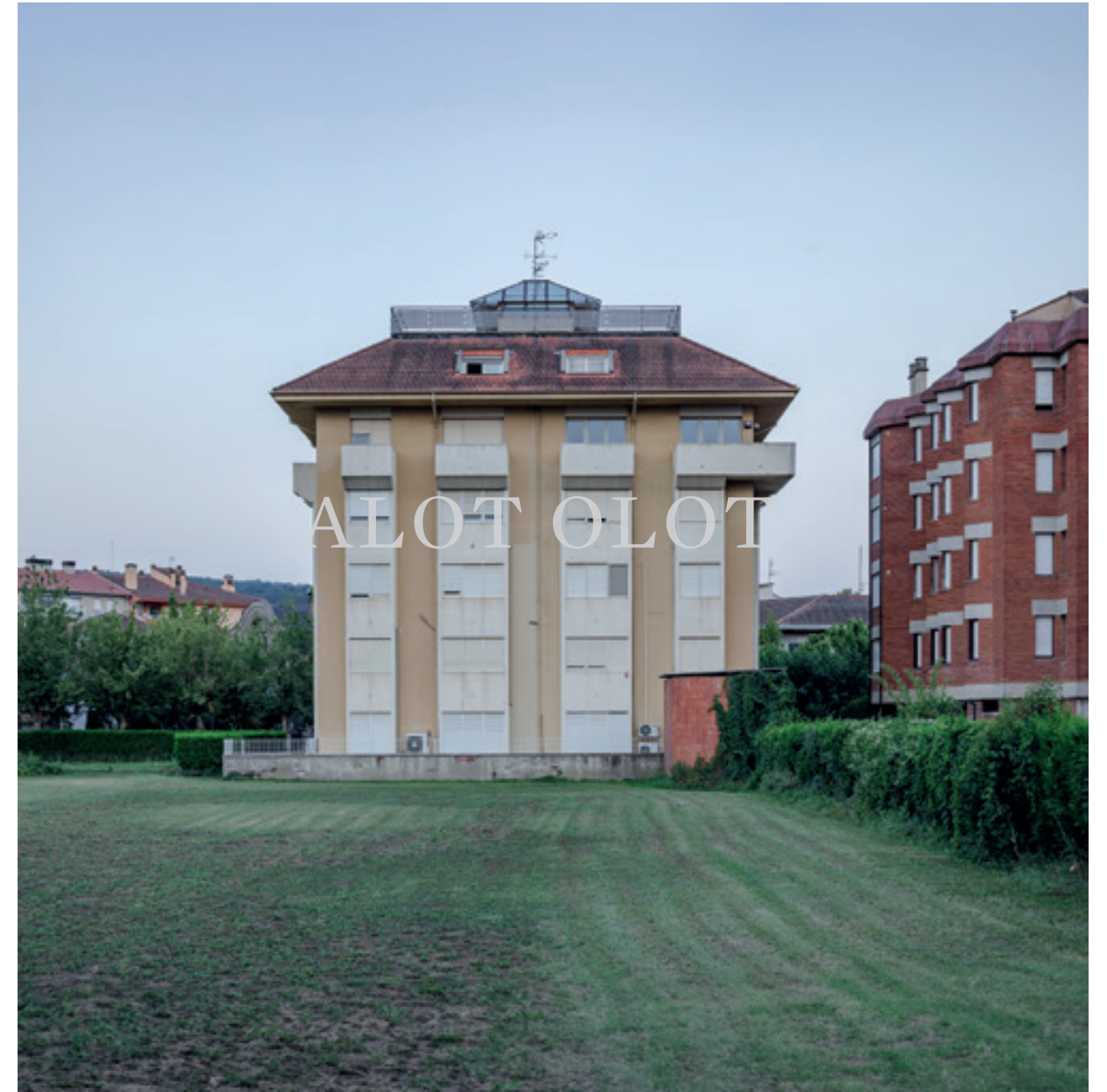
PALAZZINA ALS CAMPS DE CAN VAYREDA
