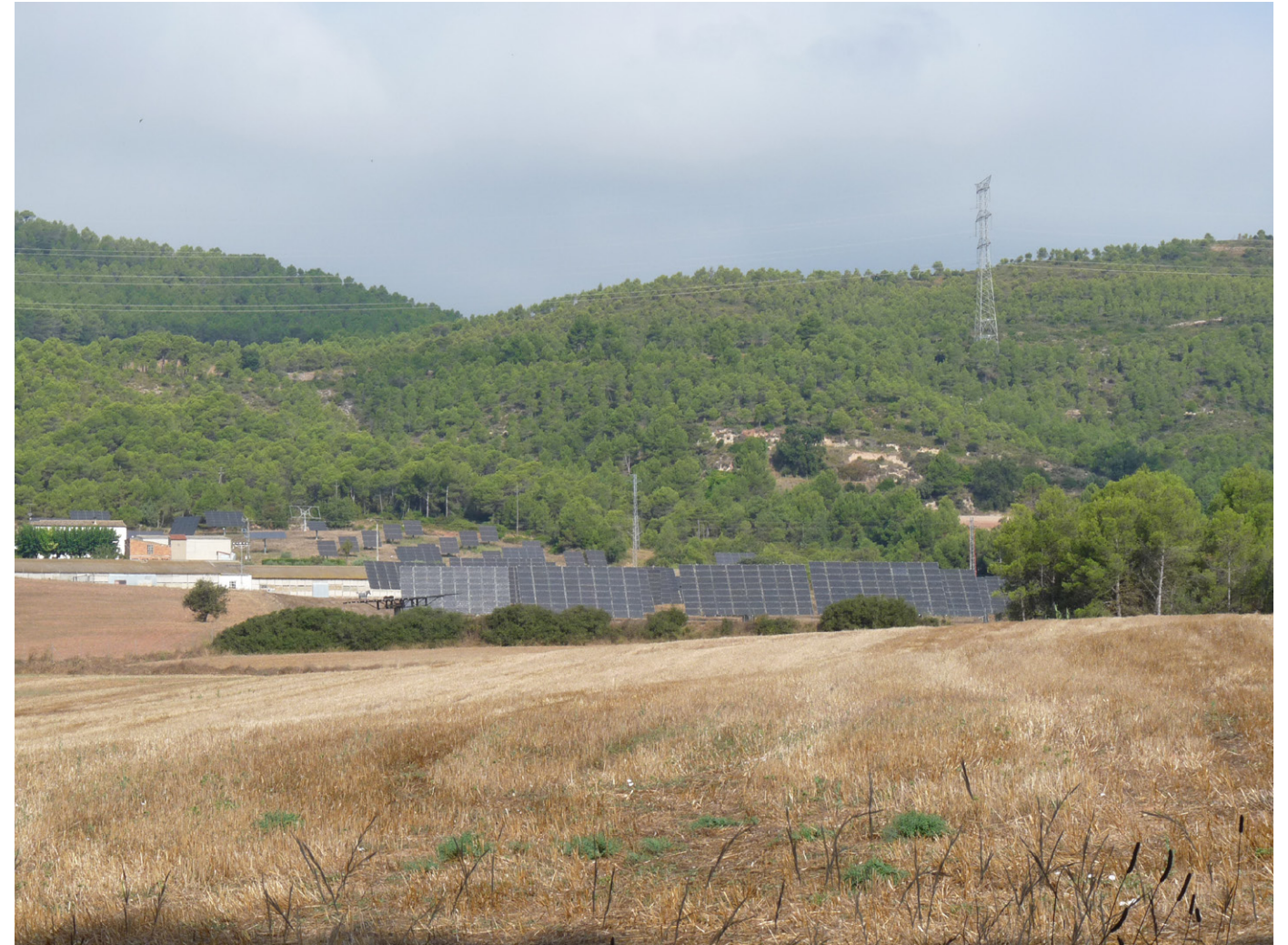
Central fotovoltaica a tocar la C-37. Joan Soler i Gironès
