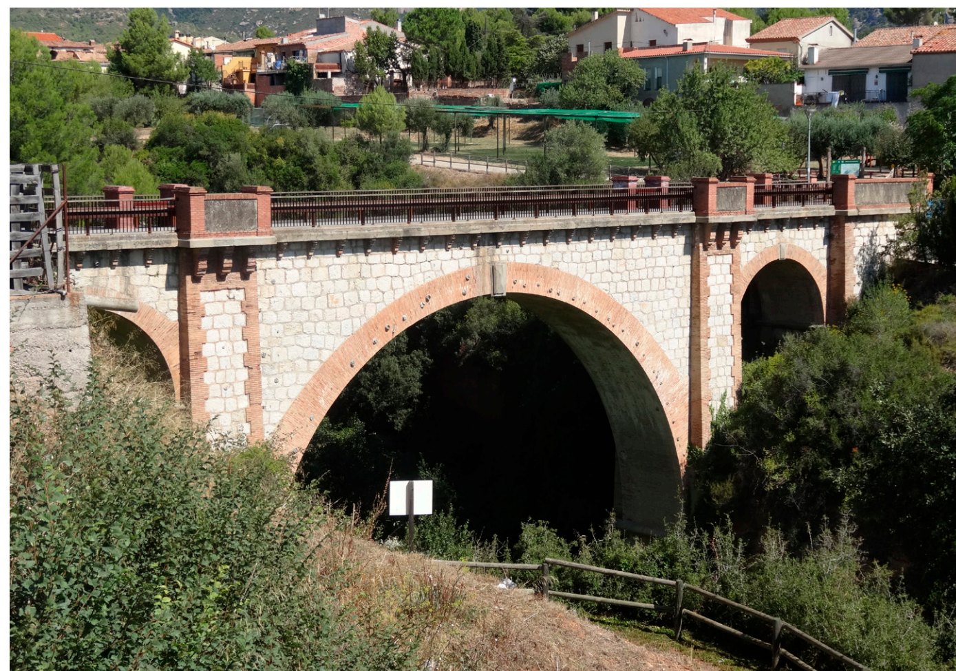
Pont de la Parròquia sobre el torrent de l'Illa que uneix els nuclis del Bruc de Baix i el de la Parròquia. Jordi Ferrer
