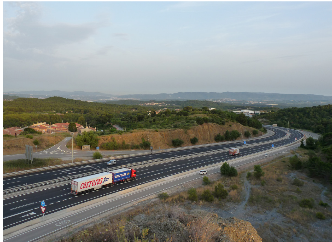
L'A-2 és la principal infraestructura que travessa la unitat, en direcció nord-oest sud-est. Joan Soler i Gironès
