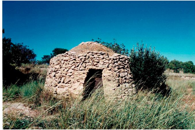
Les barraques, murs i altres construccions de pedra seca de la unitat tenen un elevat valor cultural, ecològic i paisatgístic. Grup Drac Verd de Sitges
