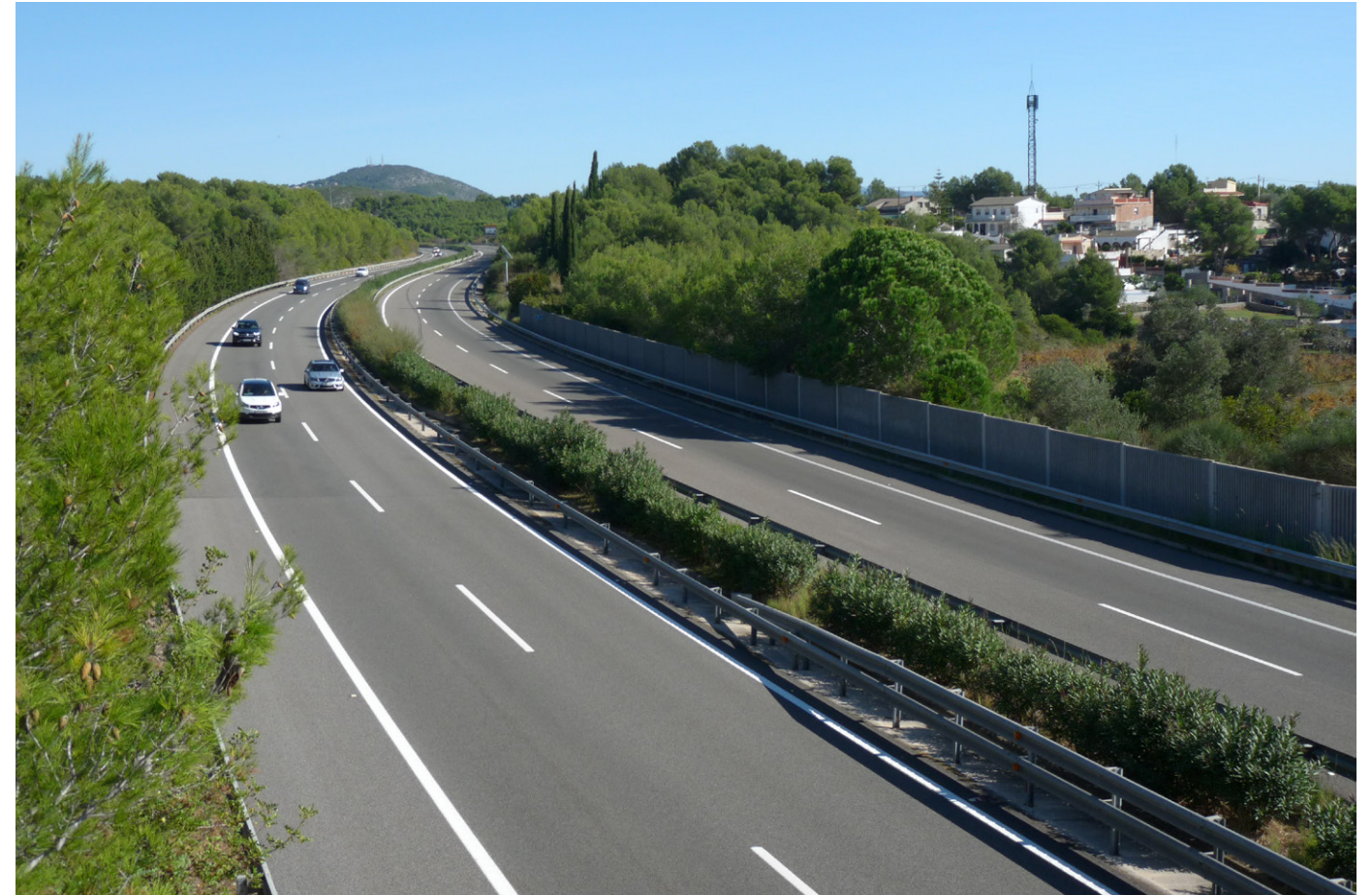
La C-32 o autopista Pau Casals és la infraestructura viària més important de la unitat i la seva construcció va modificar profundament aquest paisatge. Joan Soler i Gironès
