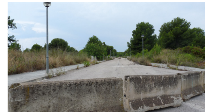
Urbanització inacabada a tocar de l'N-340 a El Francàs, municipi del Vendrell. Joan Soler i Gironès
