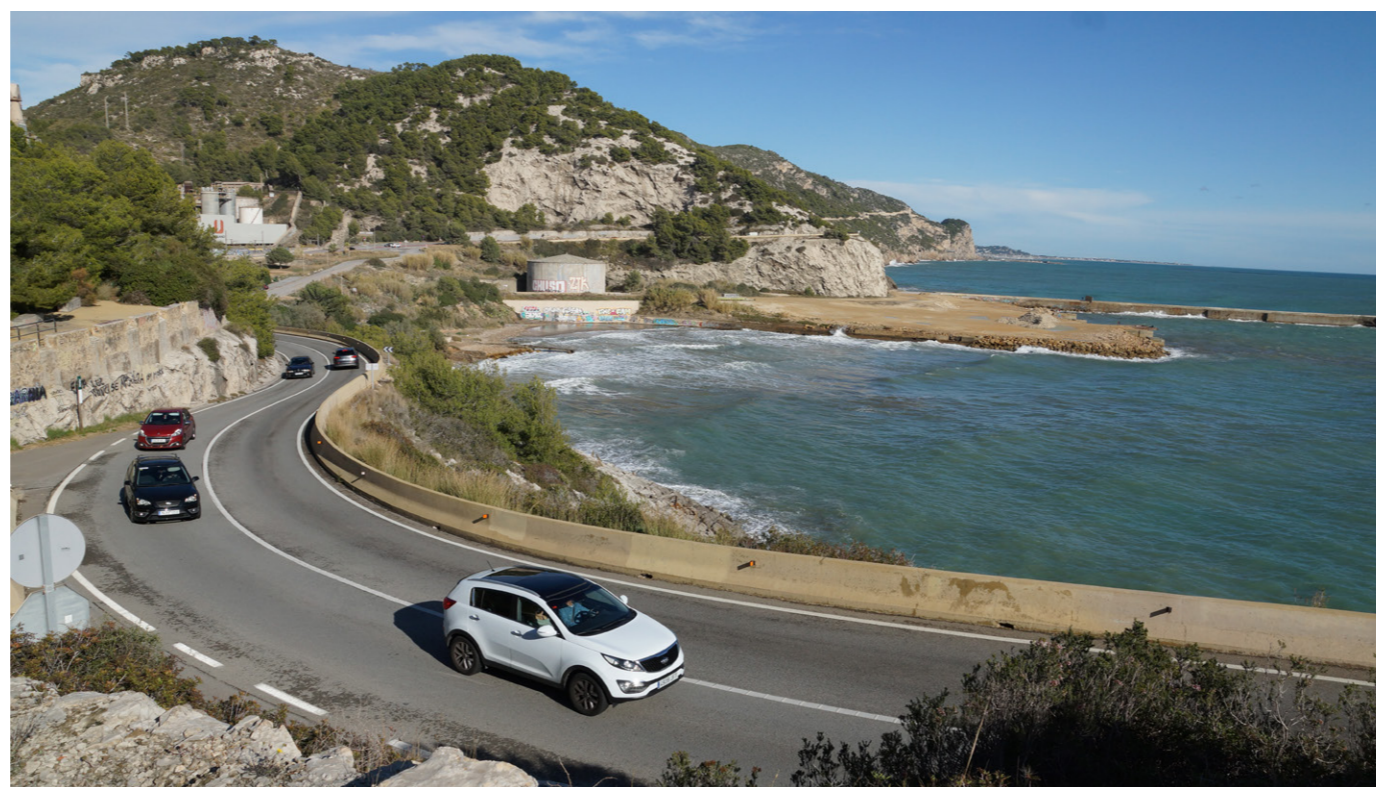
La C-31, coneguda com carretera de les Costes del Garraf, es va construir el 1879 amb un traçat sinuós adaptat a l'orografia de les muntanyes del Garraf. Observatori del Paisatge de Catalunya
