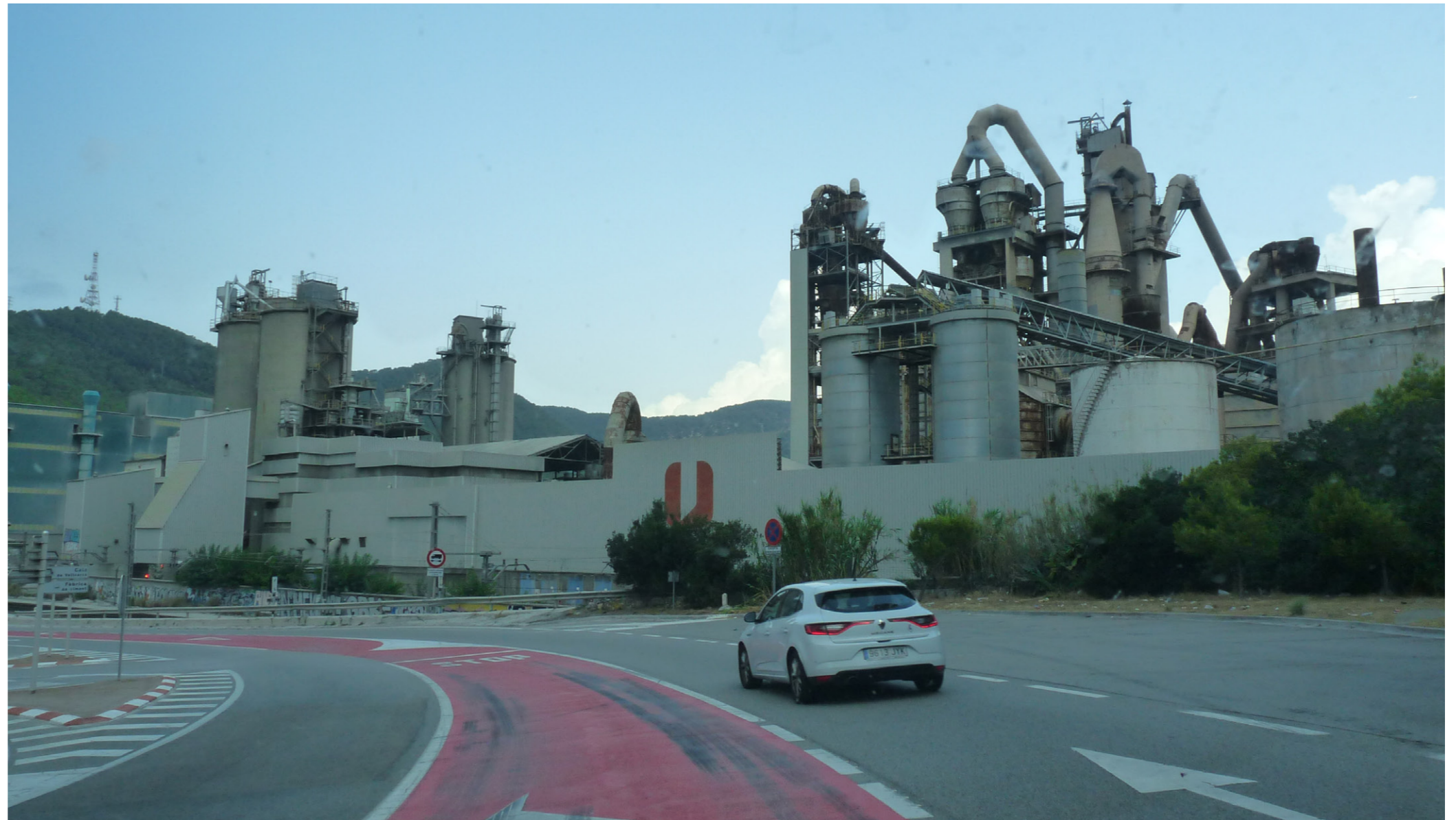
El traç de la C-31 exposa visualment les instal·lacions de la cimentera de Vallcarca amb un important impacte visual. Joan Soler i Gironès
