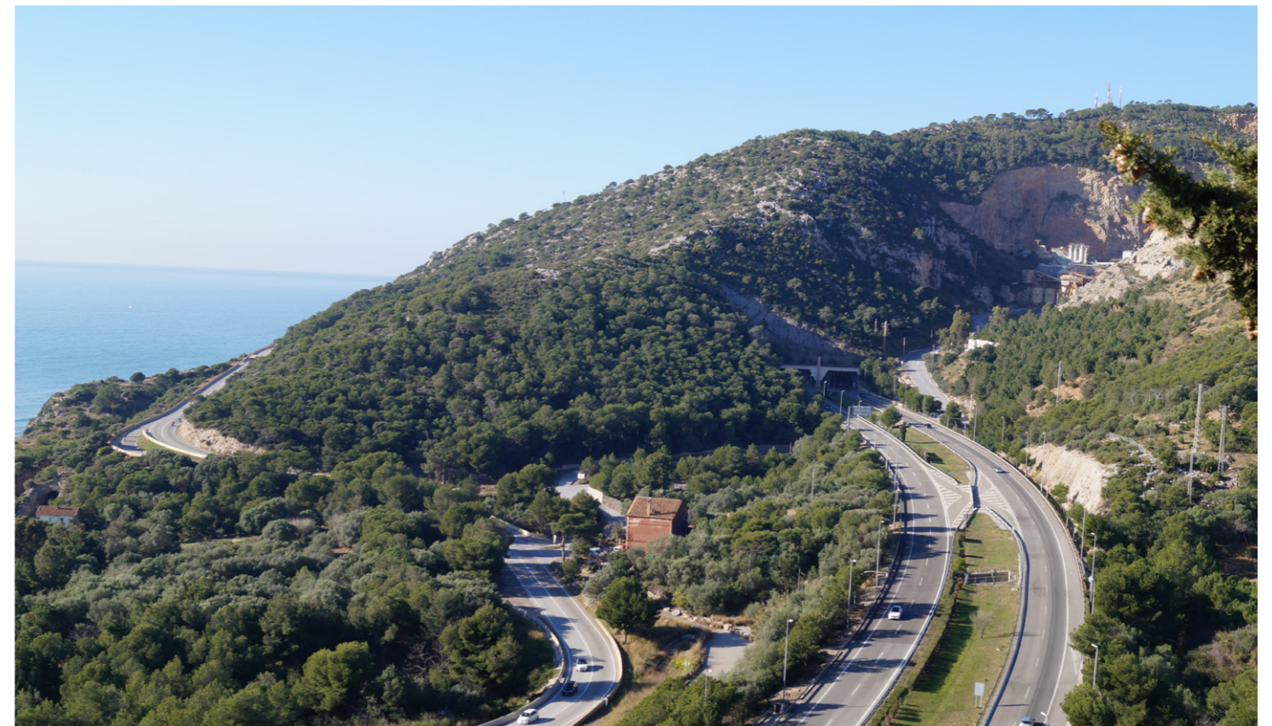
Les carreteres C-31 i C-32 segueixen un traçat paral·lel en alguns trams. La C-32 està formada per nombrosos túnels i viaductes. Observatori del Paisatge de Catalunya
