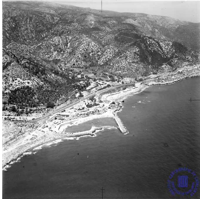
El port del Garraf es va construir a principis del segle XX per fer arribar pedra procedent de les pedreres del Garraf per l'ampliació del port de Barcelona i va afavorir la creació i creixement del poble del Garraf. ICGC, Fons SACE.
