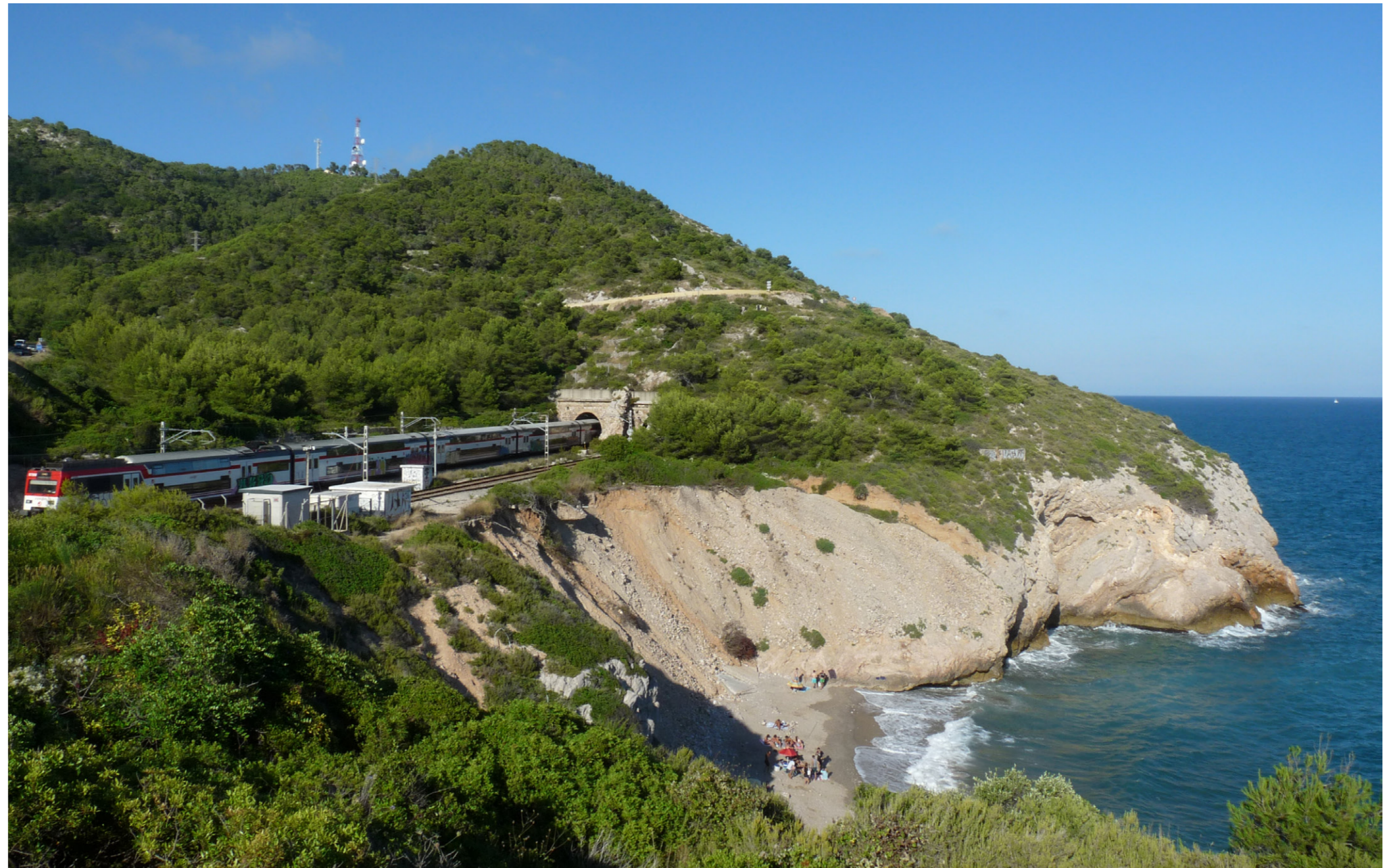
La construcció a finals del segle XIX de la línia de tren arran de mar va suposar una important obra d'enginyeria ja que circula per l'interior de nombrosos túnels i surt a l'exterior només a les cales on permet apreciar el paisatge. Biel Montoro
