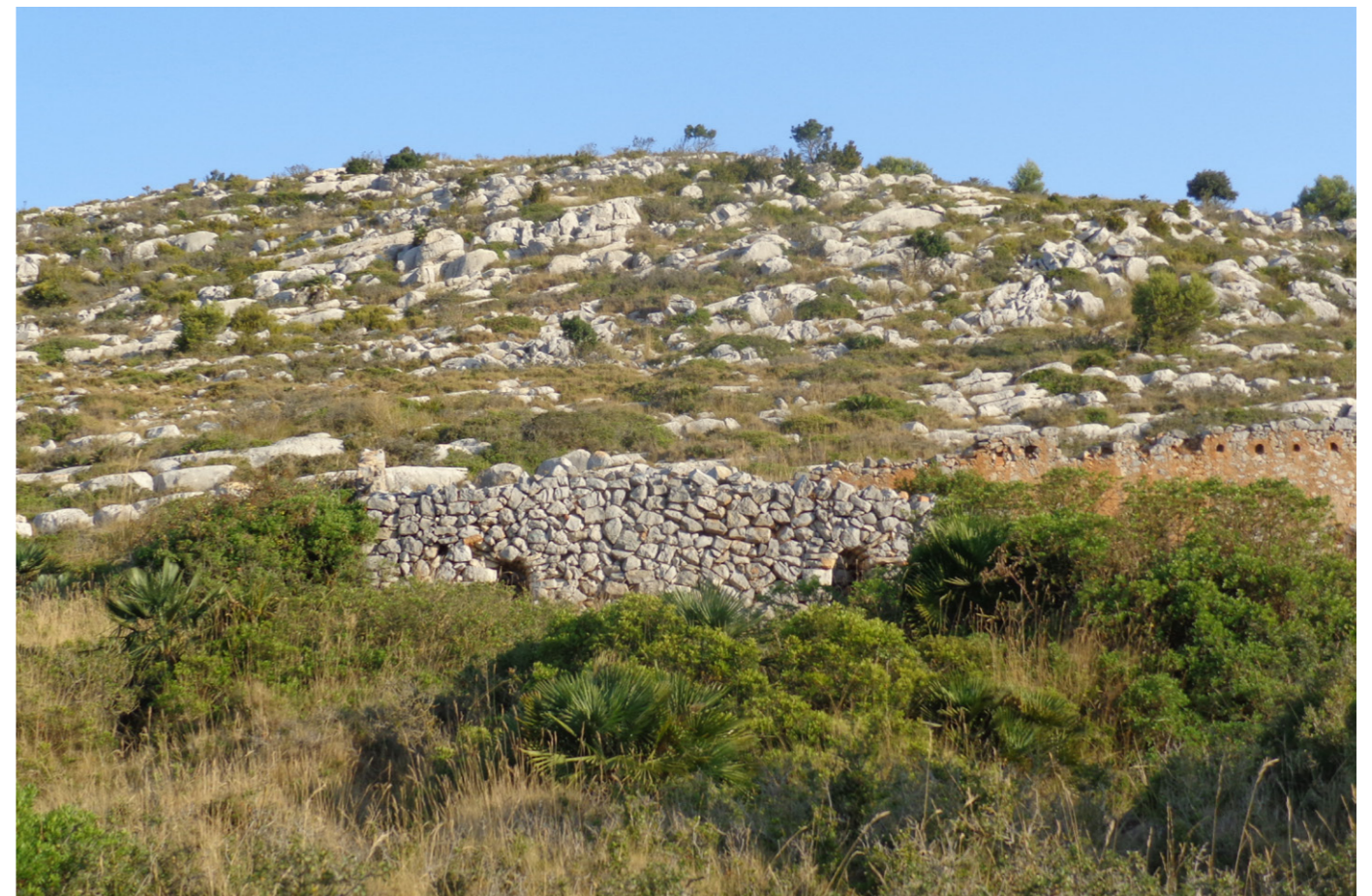
Durant segles s'ocuparen terres de difícil accés gràcies a la construcció de terrasses de pedra seca. També es construïren barraques per guardar estris o aixopluc en cas de mal temps. Ramon Artigas
