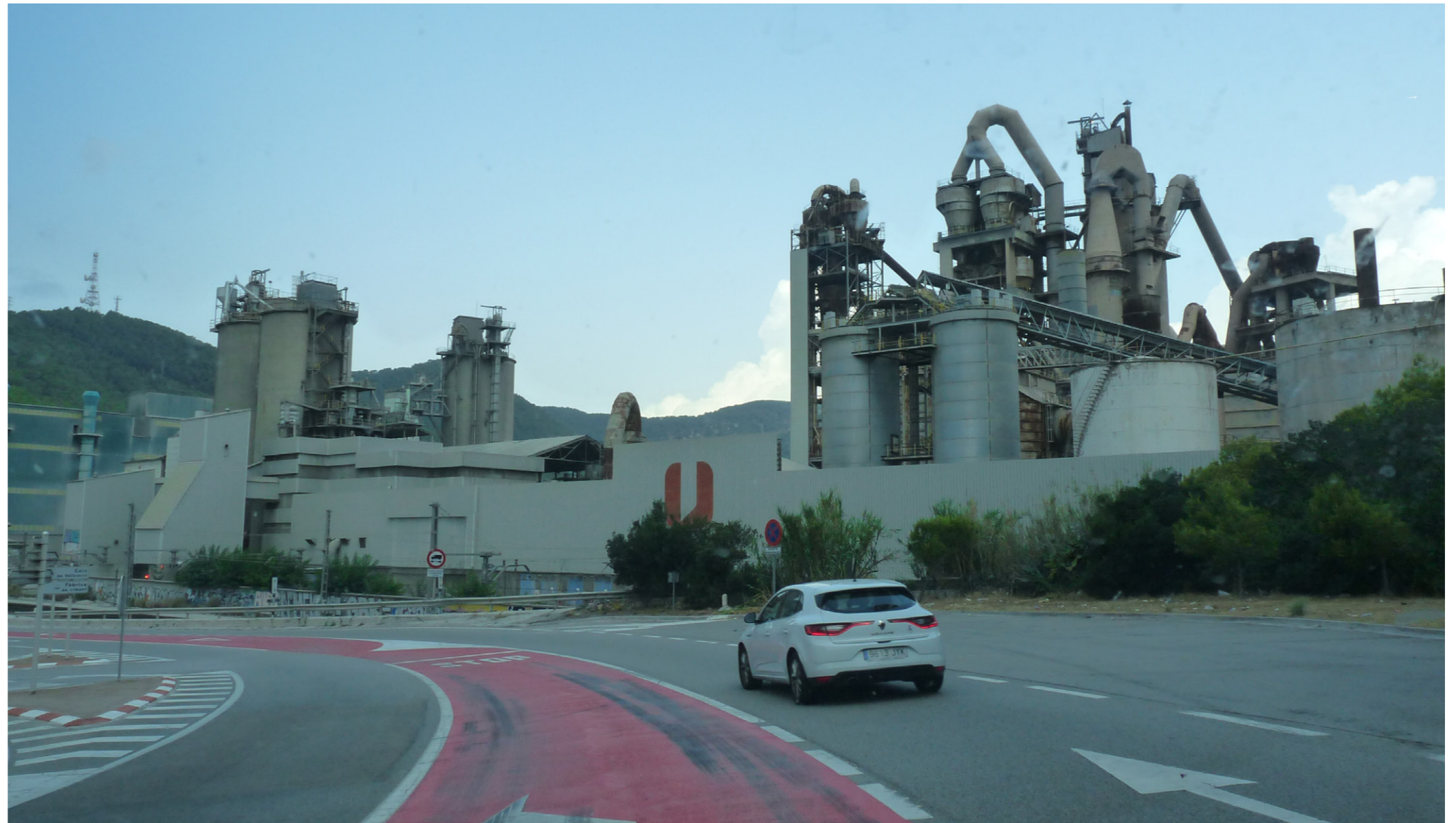
El traç de la C-31 exposa visualment les instal·lacions de la cementera de Vallcarca amb un important impacte visual. Joan Soler i Gironès
