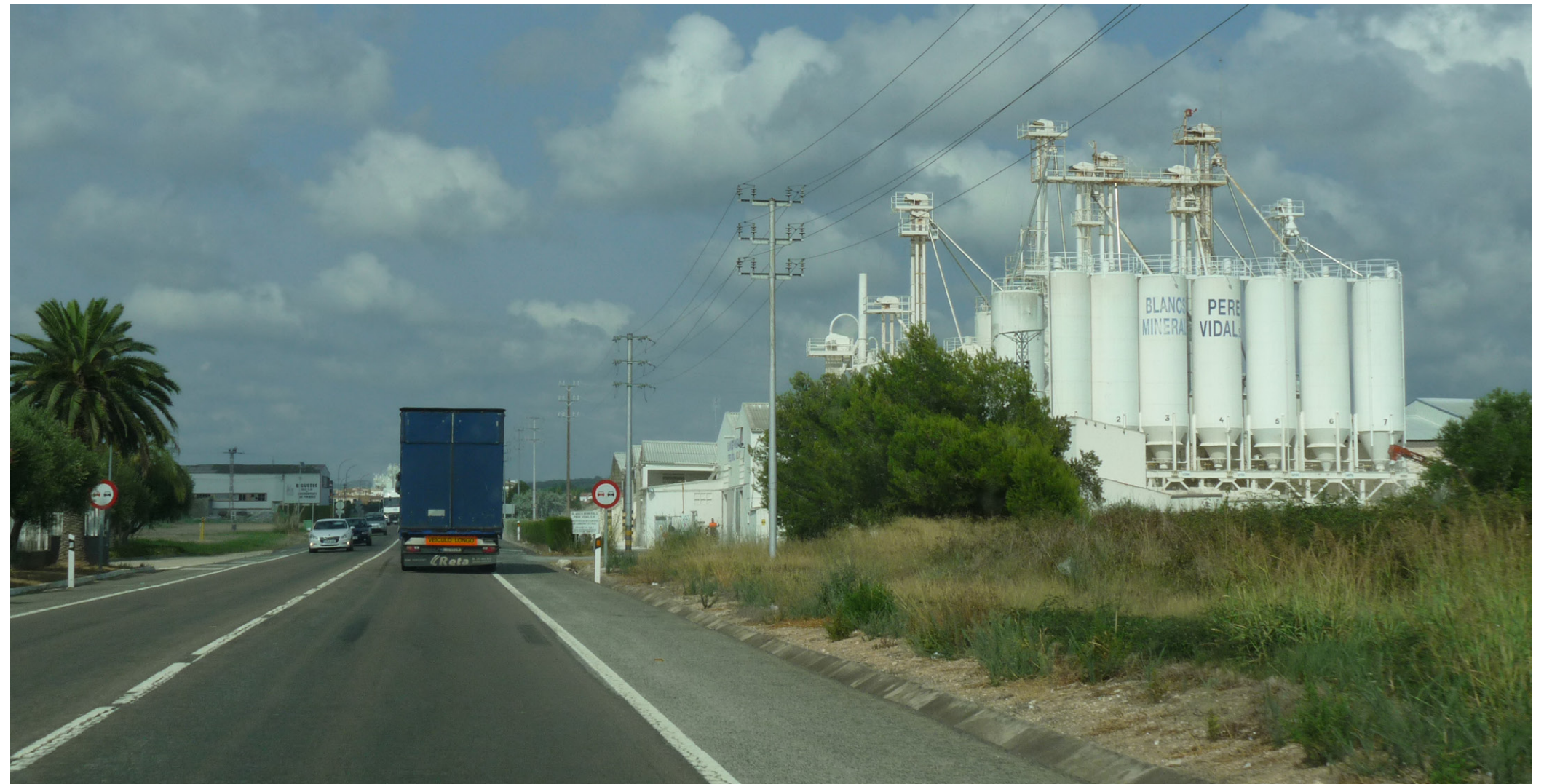
A la unitat hi ha estructures volumètriques amb funcions de contenidor que sovint són molt visibles per ubicar-se al costat de vies de comunicació. Joan Soler i Gironès
