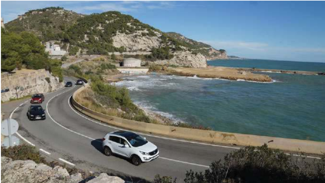
Imatge 6. Un exemple de carretera interessant però amb una excessiva intensitat de trànsit és la carretera C-31 de les costes de Garraf. Es tracta d'una via amb un indubtable interès paisatgístic amb una morfologia que la fa especialment atractiva.
