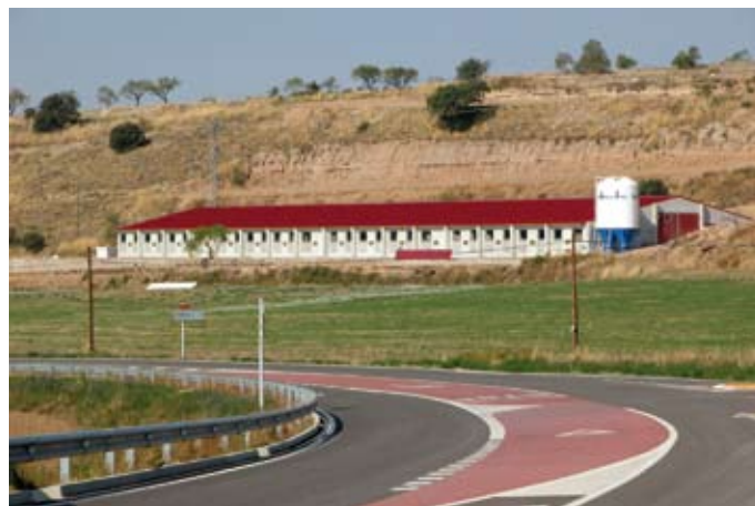
Granja de nova construcció a les proximitats de Castellmeià. Observatori del Paisatge
