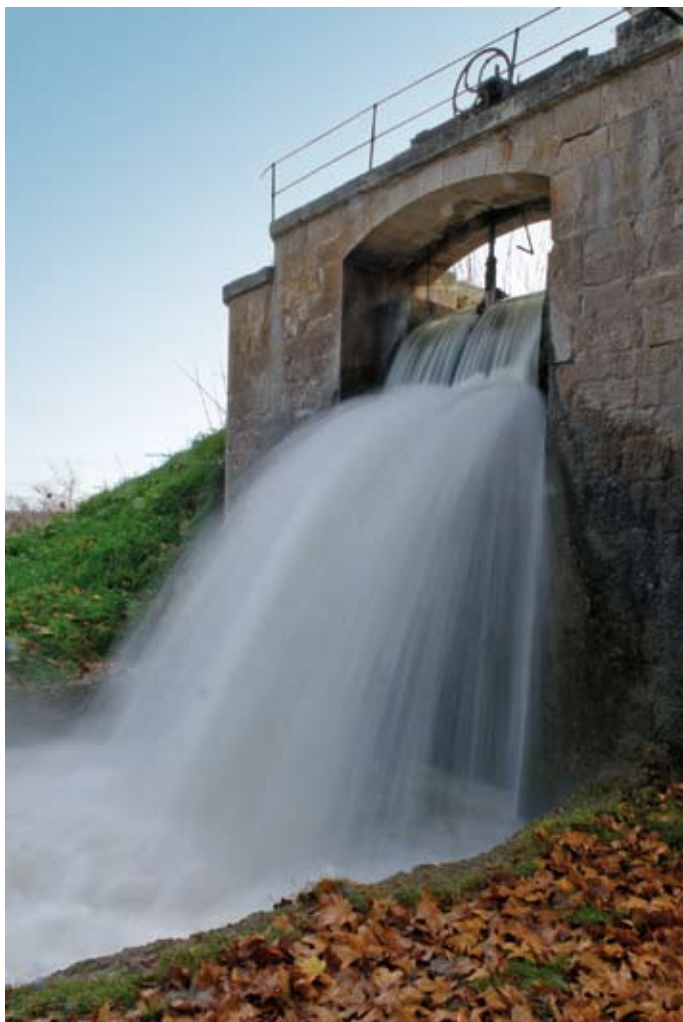
Els Salt de Duran a la sèquia tercera del canal d'Urgell, a prop de Mollerussa. DPTOP
