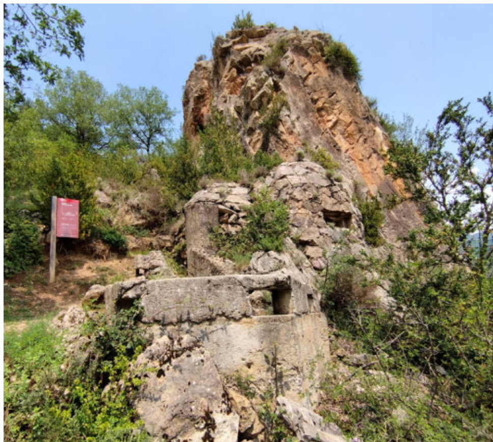
ENTRADA DEL BÚNQUER DE LA ROCA DE LA MEL AMB RECOBRIMENT DE PEDRA. El disseny dels búnquers sempre intenta integrar-los en el paisatge de cada indret perquè passin desapercebuts. En aquest cas, la pedra utilitzada per bastir murs i altres construccions de pedra seca també va ser útil per revestir alguns búnquers de l'organització defensiva dels Pirineus o Línia P, construïda durant el règim franquista.
