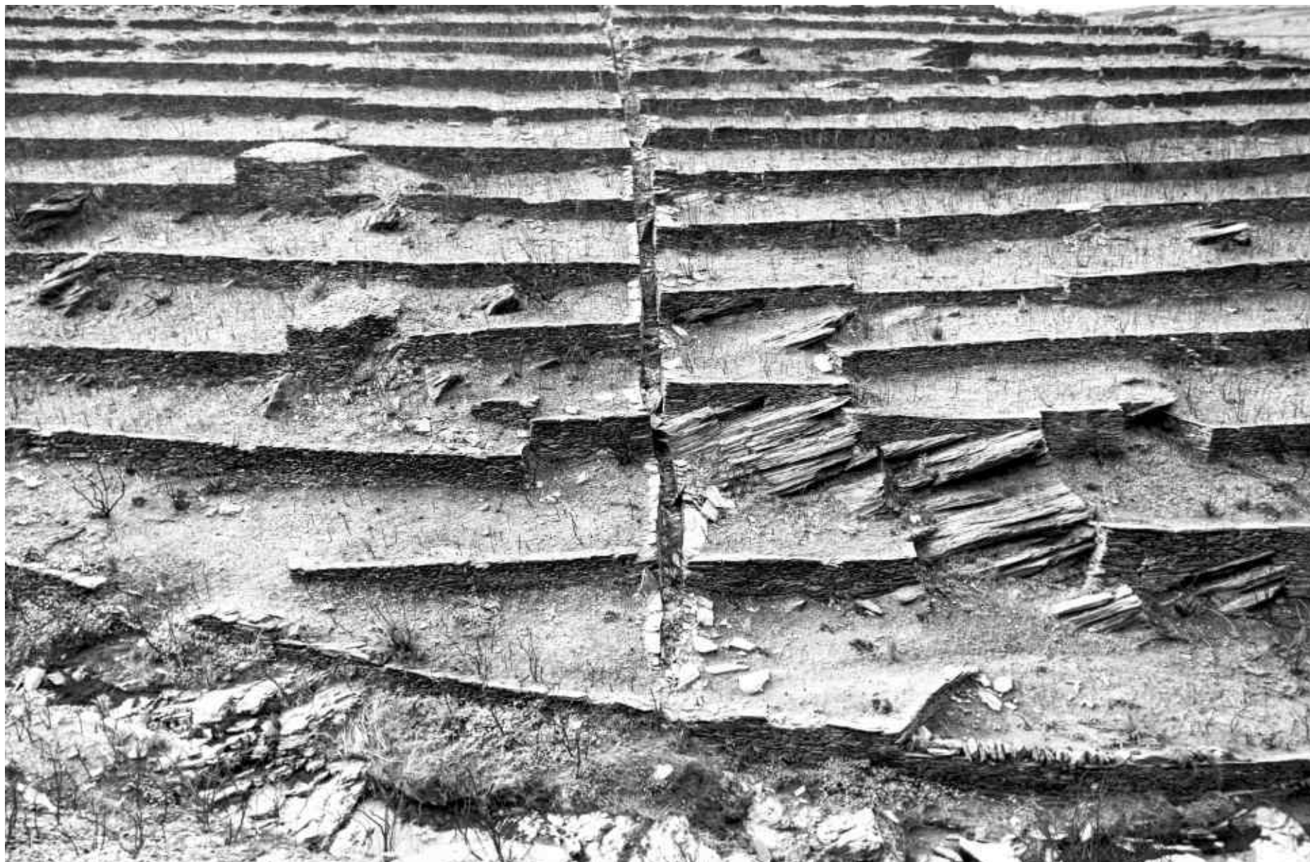
TERRASSES DE PEDRA SECA I CANALS PER EVACUAR L'AIGUA DE PLUJA. Els elements construïts amb pedra seca al Cap de Creus són molt variats, des de camins i carrerades fins a recs, passant per travesseres, clapers, fites i barraques. Al llarg d'alguns recs naturals, com en els de la fotografia, es van aixecar parets de pedra seca per poder canalitzar el volum d'aigua quan hi havia fortes precipitacions. D'altra banda, es van col·locar pedres laminars en els pendents més costeruts per empedrar camins i carrerades. També s'empraven sovint acumulacions de pedres de base cilíndrica i es formava una petita torre en la delimitació dels límits de propietat dels terrenys.
