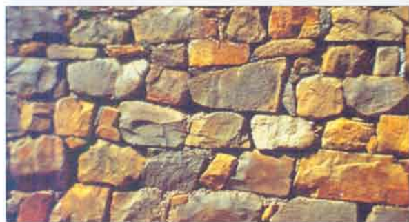
175. Muro lavorato in blocchi di arenaria. Cinque Terre (Liguria).
