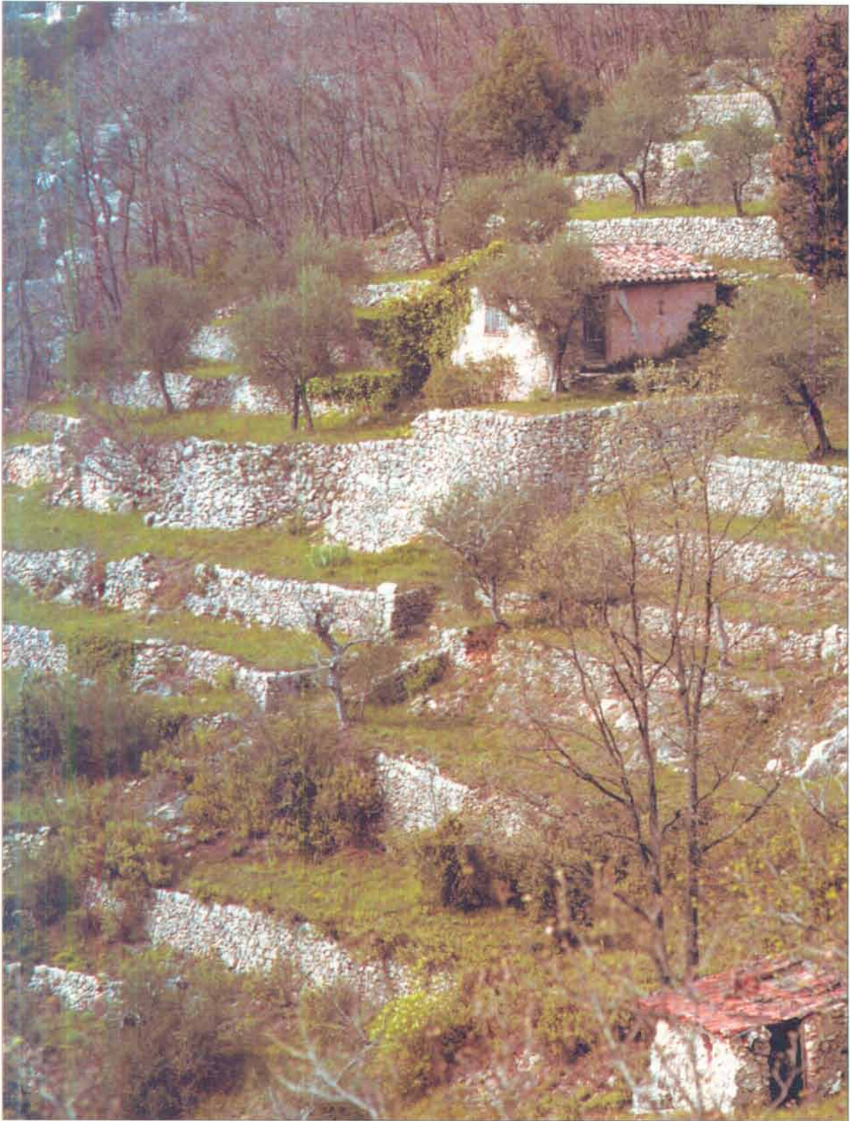
4. Marges de paredat molt adobat a la part superior de la solana de les gorges de Saint-Cézaire-sur-Siagne (Gravamoura).
