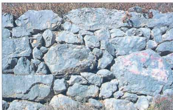
48. Marge de paredat poc adobat (Saint-Cézaire-sur-Siagne, les Faissoles, àrea B).
