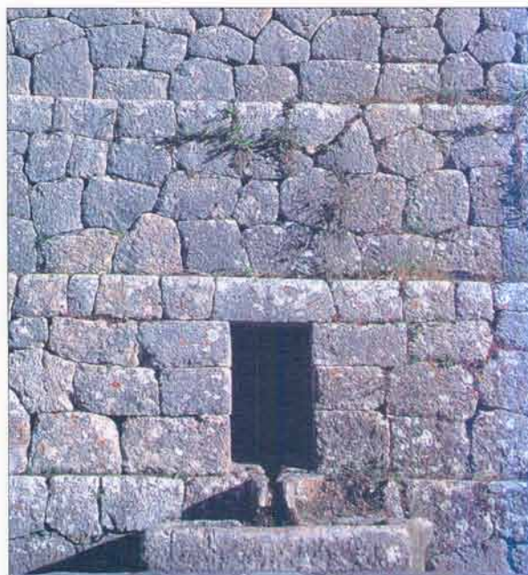
51. Marges de paredat poligonal (Bunyola, Mallorca).
