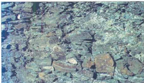
44. Marge de paredat sense adobar, bastit amb esquerdes d'esquistos argilosos (Cinque Terre, Ligúria).
