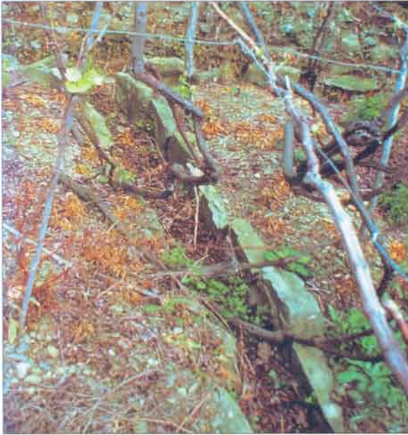
80. Exemple de petita canalització realitzada a la zona d'impluvi de les marjades concèntriques del sector de Porciano (Cinque Terre, Ligúria).
