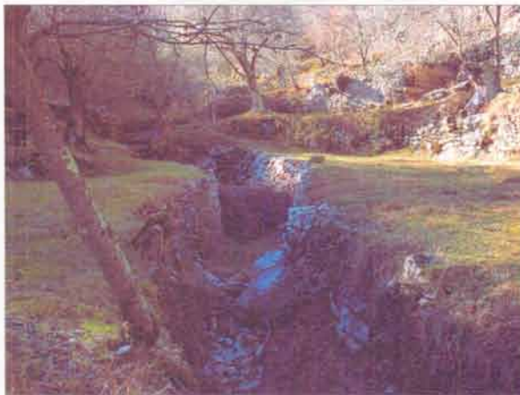
231. L'aménagement du talweg permet de maîtriser l'écoulement du ruisseau du vallon du Peuil (Breil-sur-Roya, aire A, Lavina).
