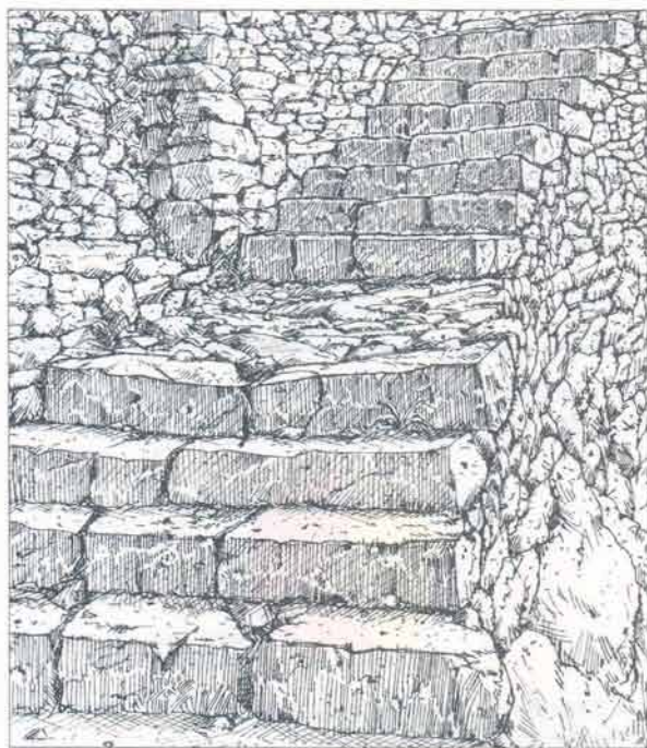
176. Esempio di scalinata addossata laterale in lastre di calcari marnosi.
