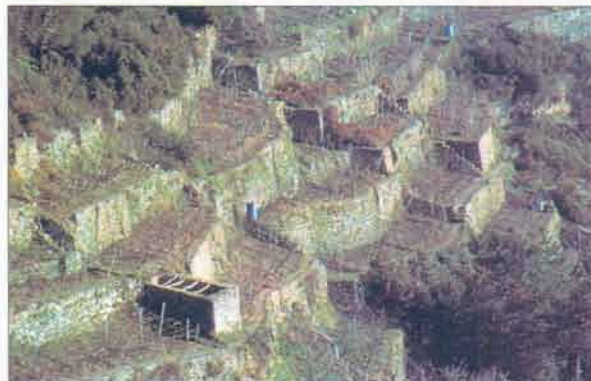
170. Terrazzamenti paralleli discontinui caratterizzati dalla presenza di molteplici opere in pietra a secco, quali scale laterali addossate ed integrate e casolari.
