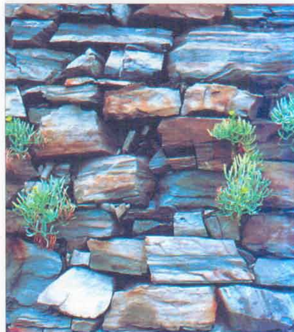
43. Marge de paredat poc adobat, bastit amb blocs de siltites (Cinque Terre, Ligúria).
