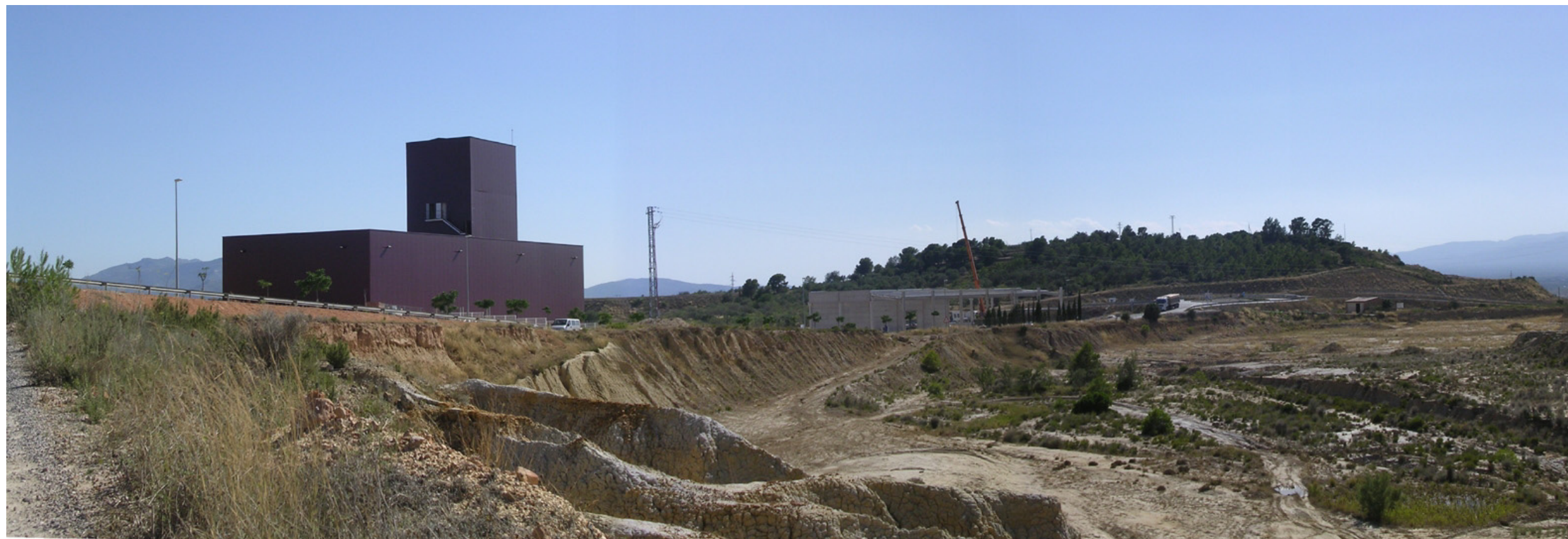
Figura 14.9. Les àrees especialitzades existents a les Terres de l'Ebre, com el polígon industrial Catalunya Sud que es pot veure a la imatge, han d'emprendre mesures de reducció del seu impacte visual així com altres millores per a la seva integració paisatgística.
