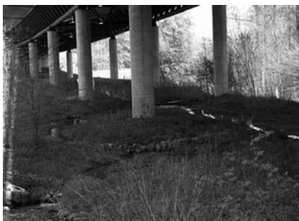
Imatge 8. Detall del condicionament sota el viaducte.
