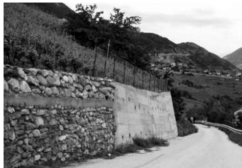
Imatge 3. Estructures de contenció amb formigó i pedres naturals.
