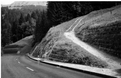
Imatge 2. Estructures de contenció amb recobriment vegetal.
