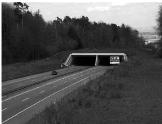
Imatge 7. Pas superior específic per a animals de grans dimensions.
