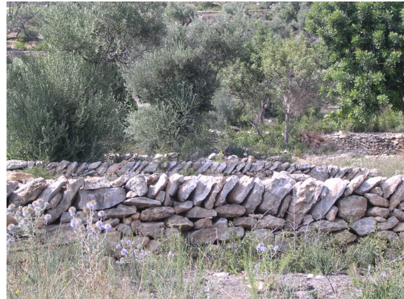
Figura 13.23. Marges de pedra en sec fets amb taperot al litoral del Baix Ebre.
