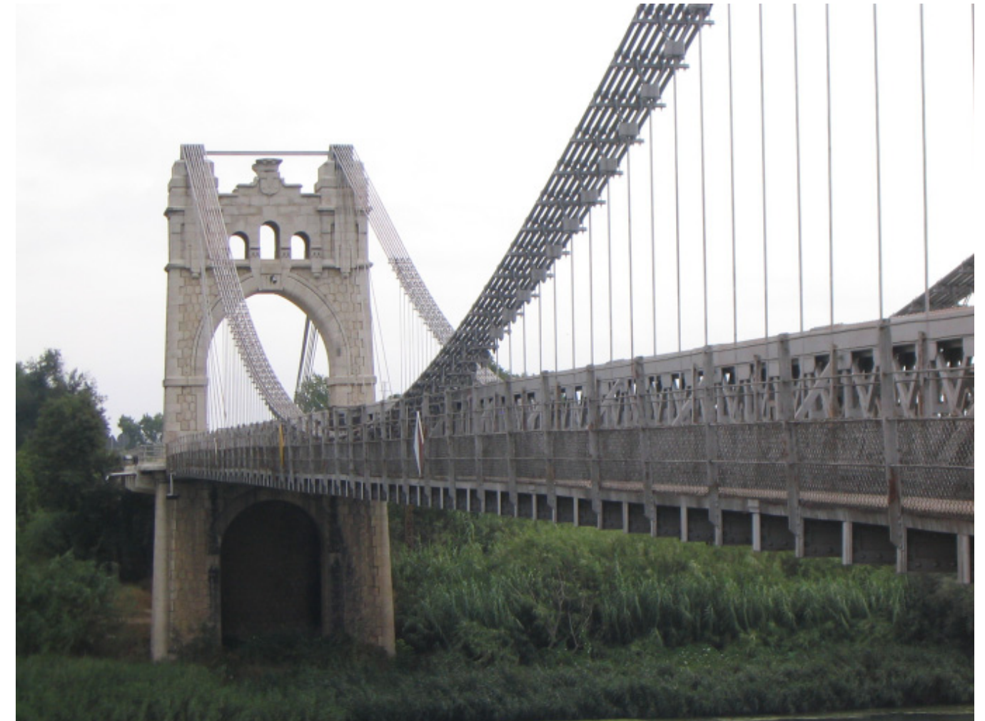
Figura 13.6. Pont penjant d'Amposta.
