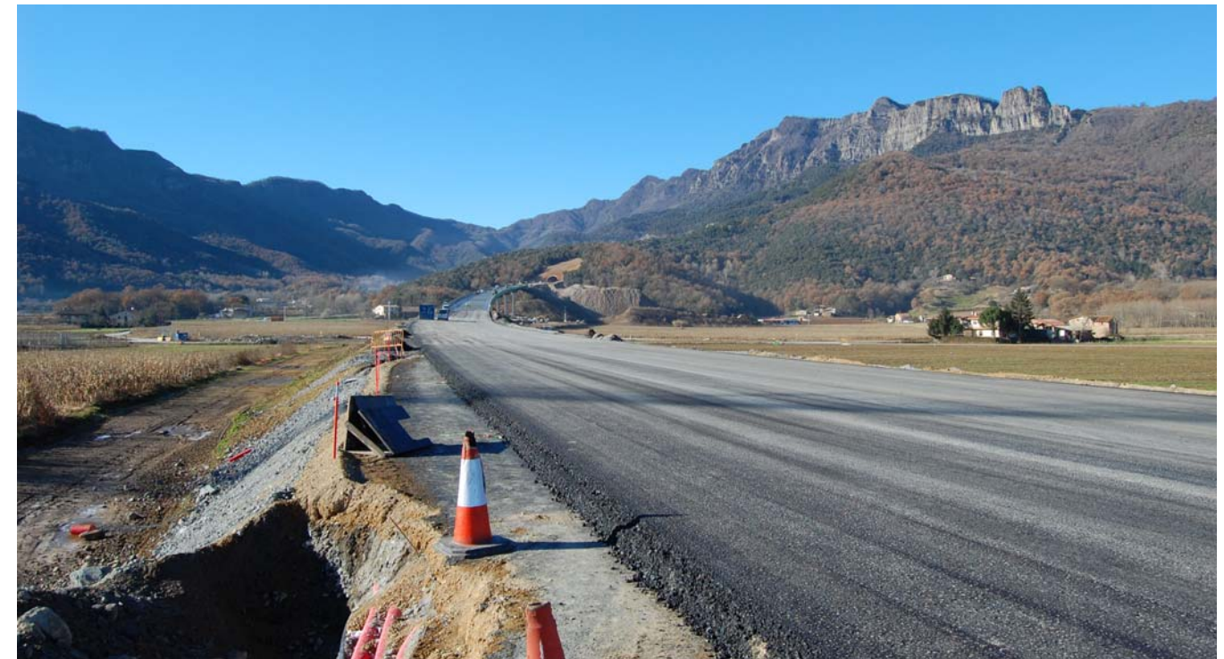
Figura 12.10. Construcció dels accessos al túnel de Bracons.
