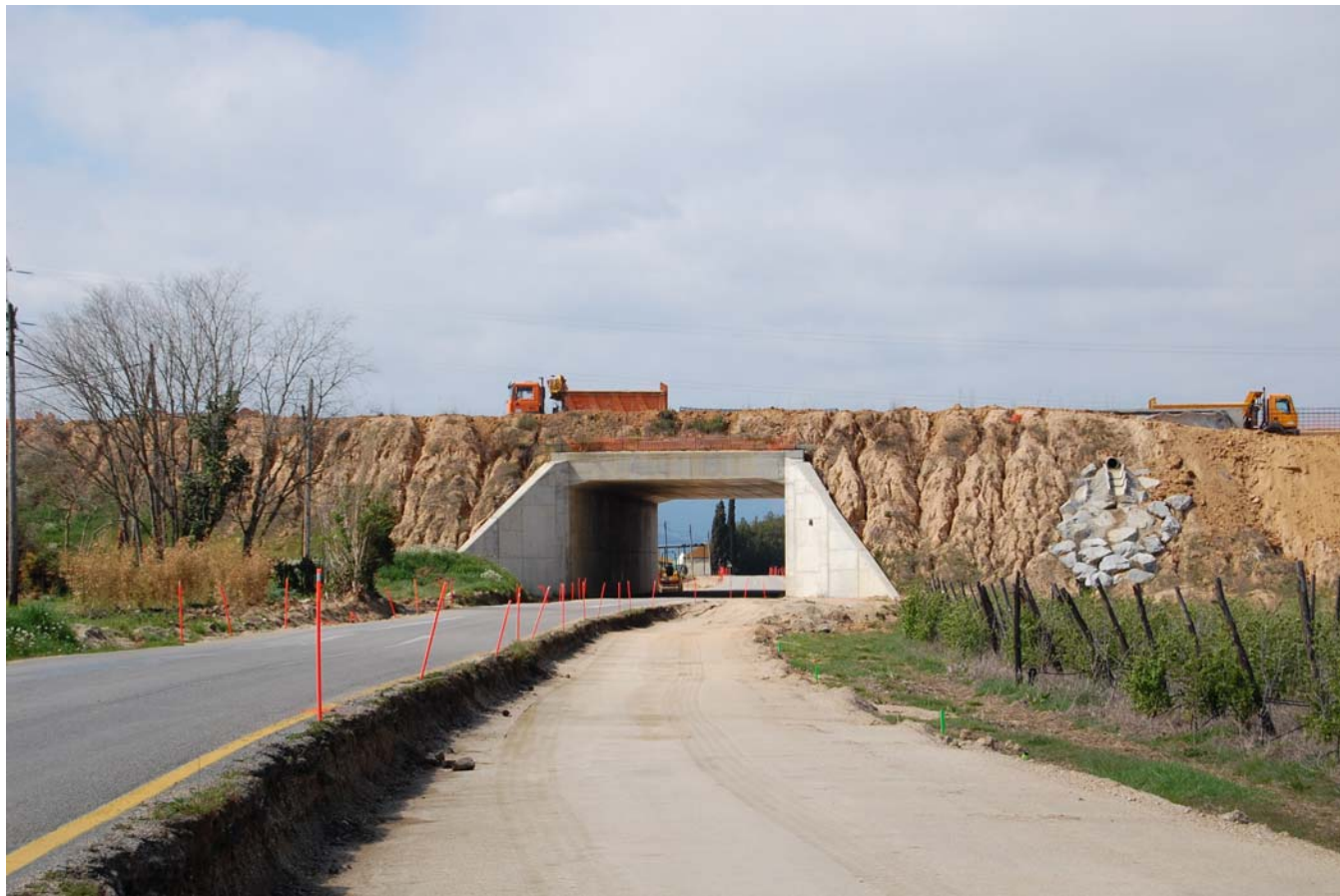
Figura 12.6. Construcció de la línia del TAV a Riudellots.
