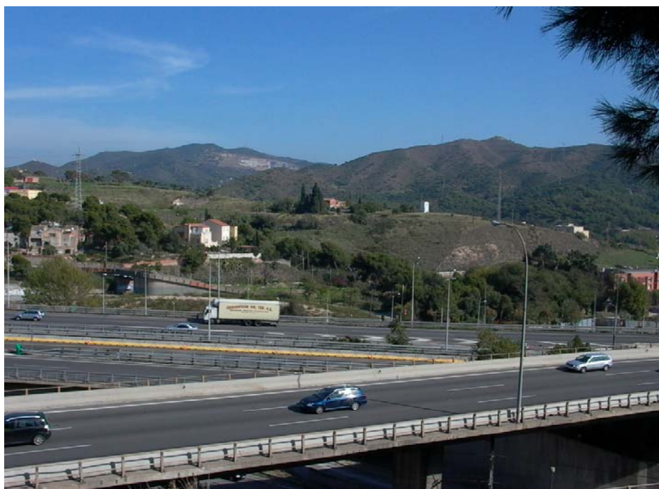
Figura 12.23: Els espais que limiten amb les grans infraestructures de mobilitat són els més exposats visualment.
