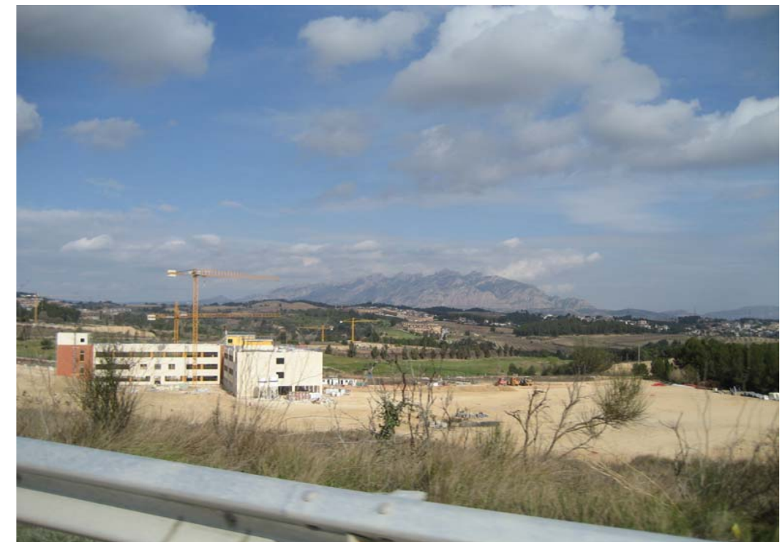
Figura 12.12: L'aplicació dels criteris paisatgístics de la Carta del paisatge de l'Alt Penedès ha de permetre una millor integració entre els nous elements construïts i l'entorn.
