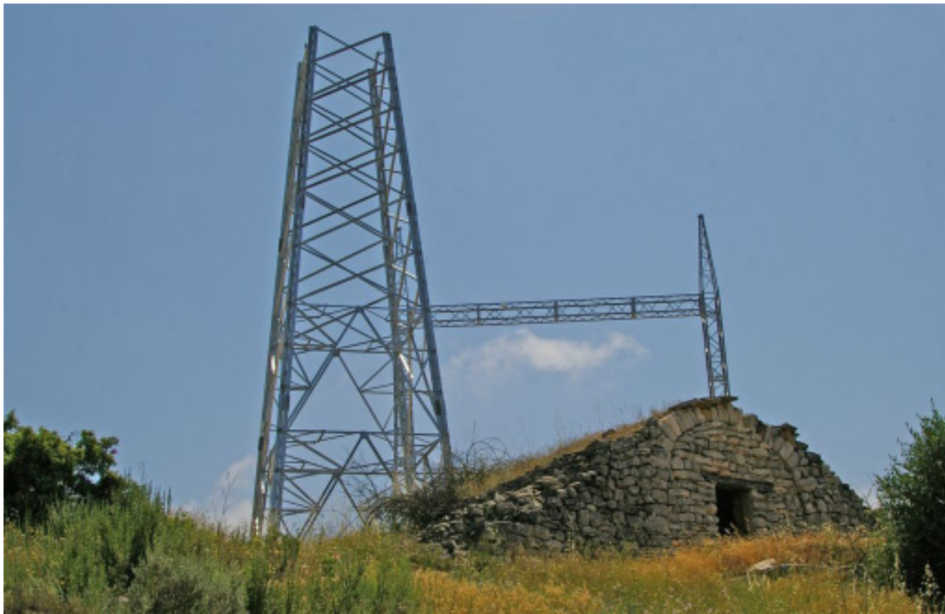
Figura 11.4. Construcció d'una torre d'alta tensió i una subestació elèctrica a l'Altiplà de la Terra Alta.
