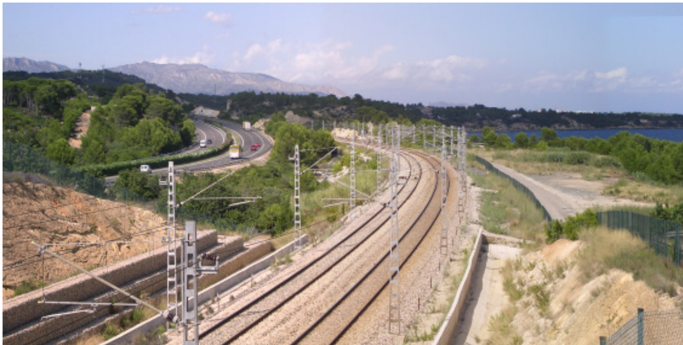
Figura 11.8. Els sectors del litoral del Baix Ebre compten amb nombroses d'infraestructures de comunicació, com el de la imatge prop del Cap Roig.
