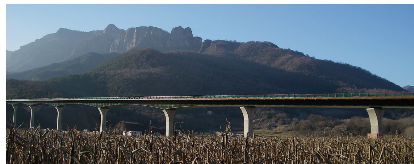
Figura 11.3. Viaducte de Mas Rubió (C-37).
