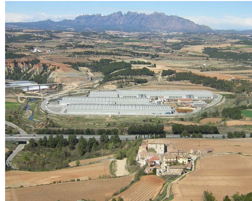
Figura 11.4: L'alta exposició visual dels nombrosos polígons industrials condiciona la percepció dels paisatges de la Regió.
