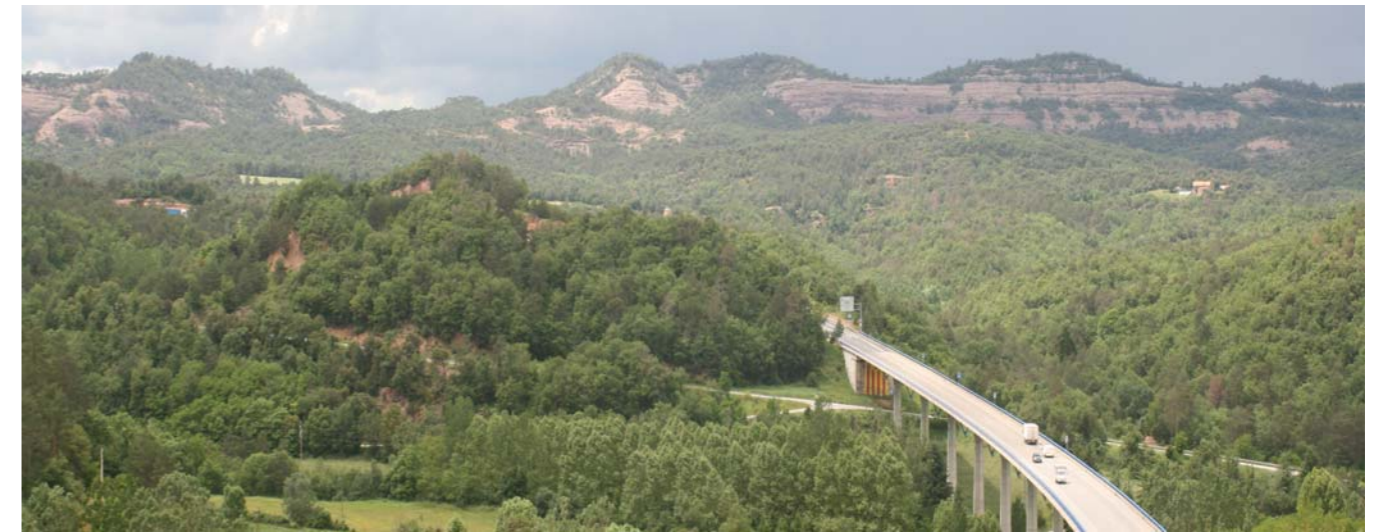
Figura 10.10. Viaducte de Sant Sadurní d'Osormort. Guilleries.
