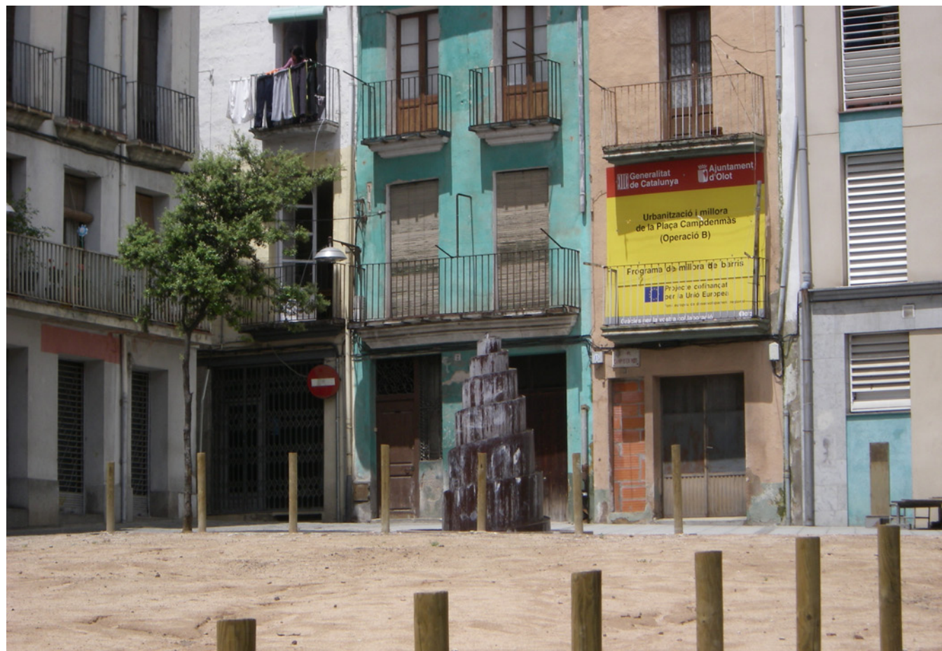
Figura 9.10: Rehabilitacions finançades pel Programa de millora de barris al nucli urbà d'Olot.
