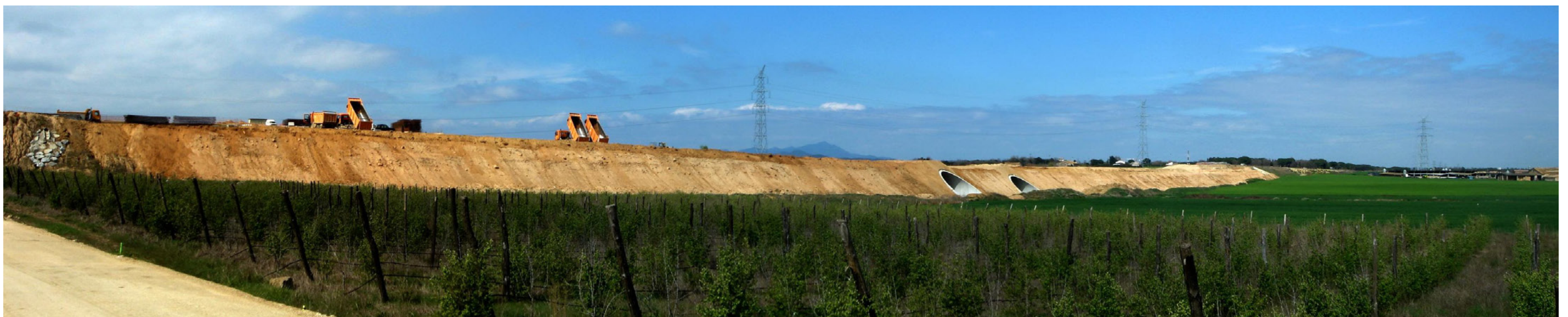
Figura 9.17: Obres del tren d'alta velocitat a l'alçada de Vilobí d'Onyar.
