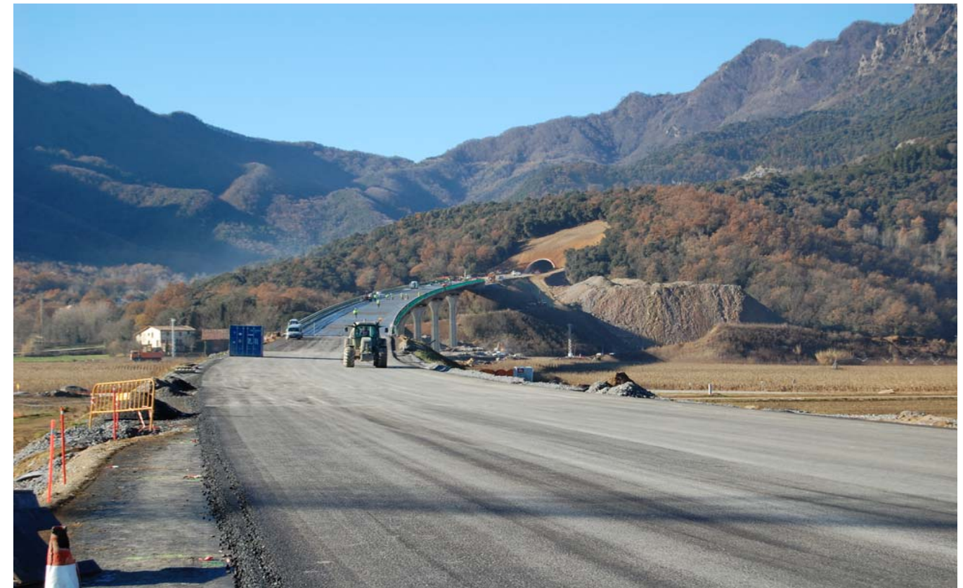
Figura 9.19: Obres del viadute de Mas Rubió (C-37), en plena Vall d'en Bas.
