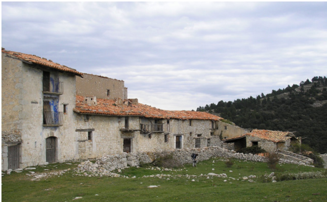
Figura 9.7. L'abandonament de les activitats agràries i forestals a les serres comporta el deteriorament i la desaparició del patrimoni arquitectònic associat. A la imatge, el Mas Blanc, als Ports.
