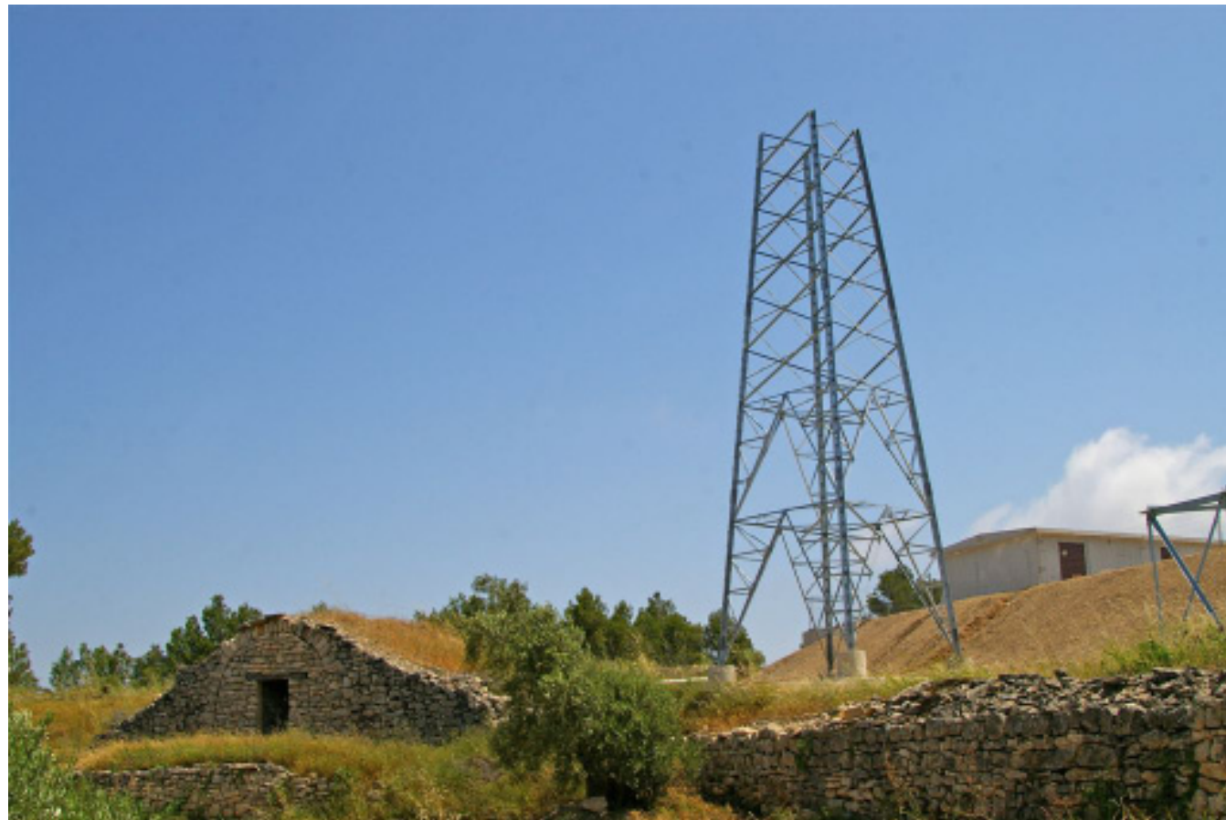
Figura 9.4. Construcció de la línia d'alta tensió per evacuar l'electricitat produïda pels parcs eòlics.
