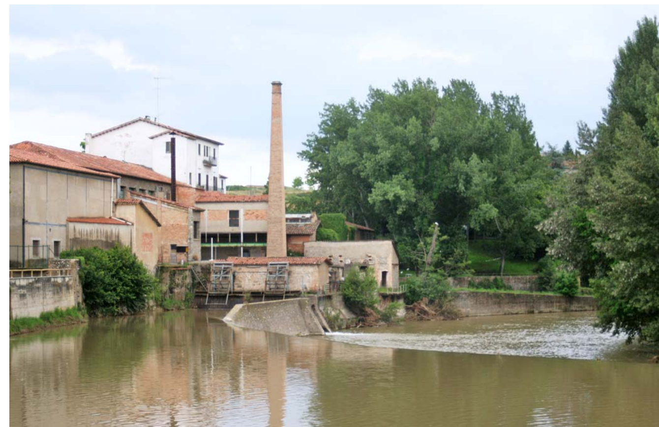
Figura 9.8 El patrimoni industrial amb valor històric és elevat als rius de les Comarques Centrals, especialment al Ter i Llobregat. Resclosa i fàbrica a Manlleu, Plana de Vic.
