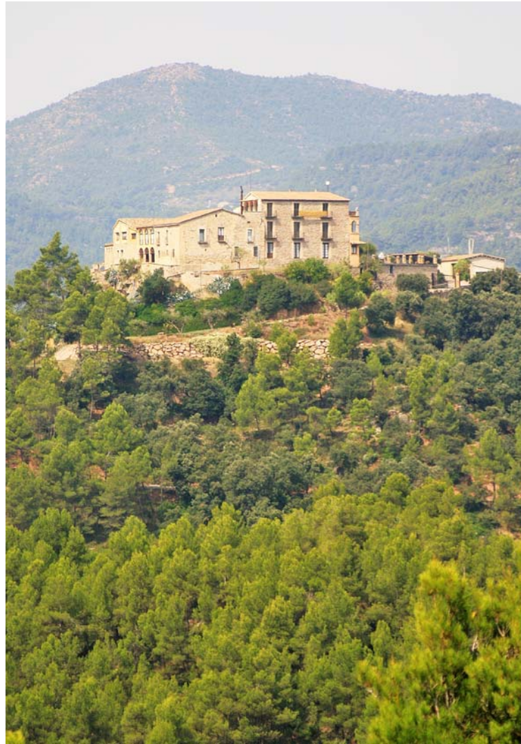
Figura 8.6: Can Miralda i, al fons, la Pòpia del Montgròs, a Sant Salvador de Guardiola, Pla de Bages.
