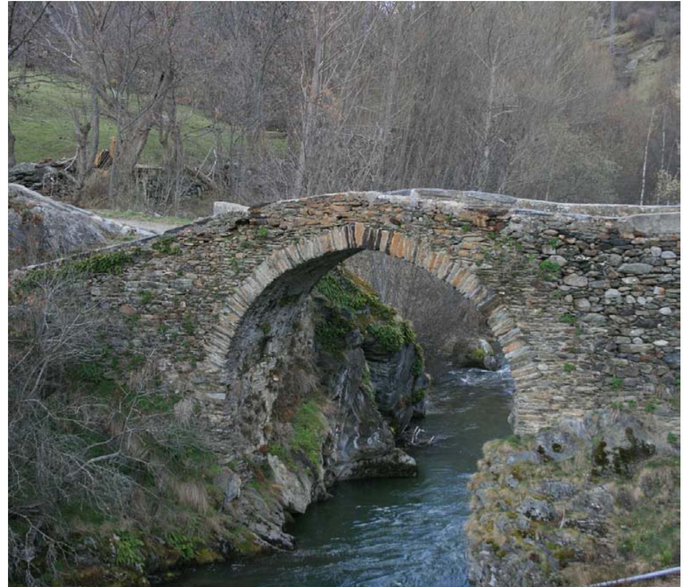
Figura 7.28. Un dels diversos ponts antics que creuen la Noguera de Cardós, en una zona amb una densitat única al Pirineu català de construccions civils d'aquest estil
