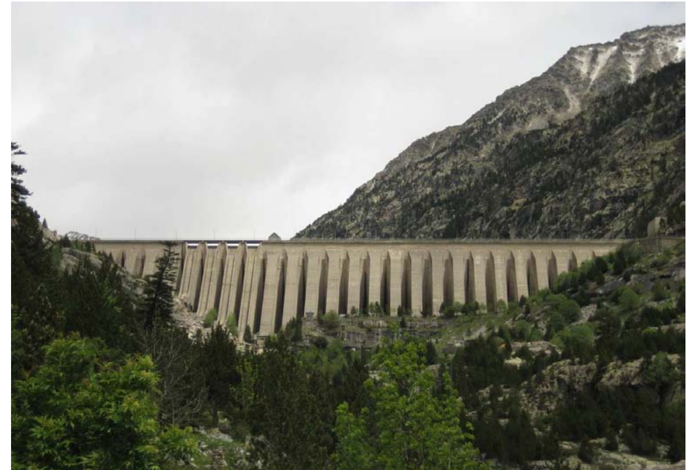
Figura 7.31. La presa de Cavallers, a la ribera de Caldes, és una infraestructura que defineix el paisatge de la zona
