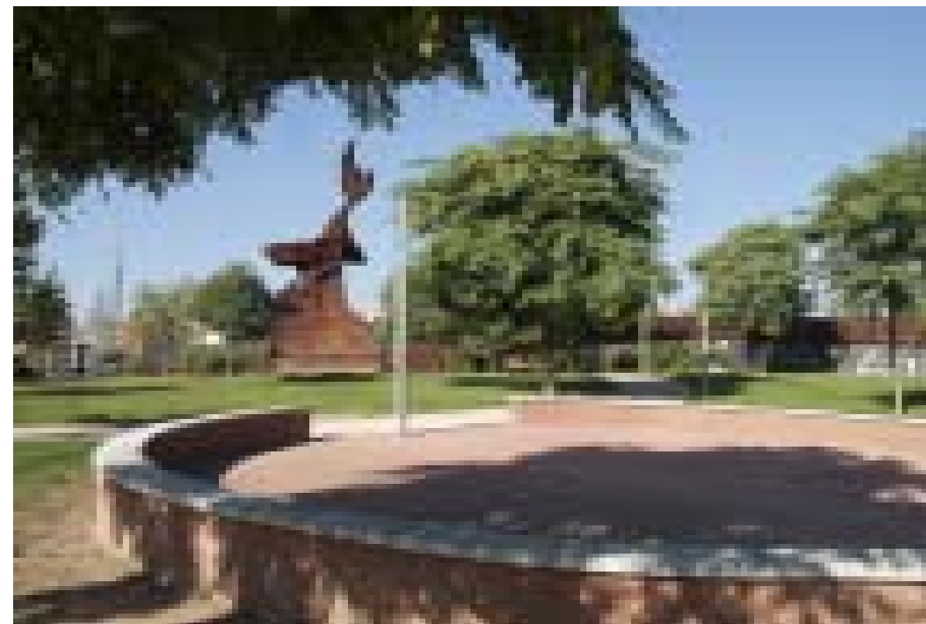
Figura 7.30: El paisatge urbà conformat pel parc i el pont del riu Ripoll (Ripollet) és un exemple d'espai públic que ha guanyat significat i per extensió valor.
