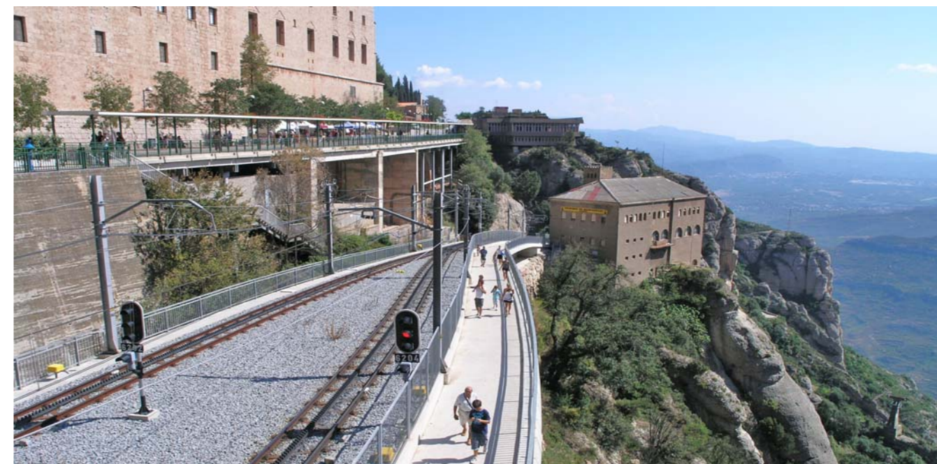
Figura 5.20: Infraestructura ferroviària del cremallera de Montserrat.
