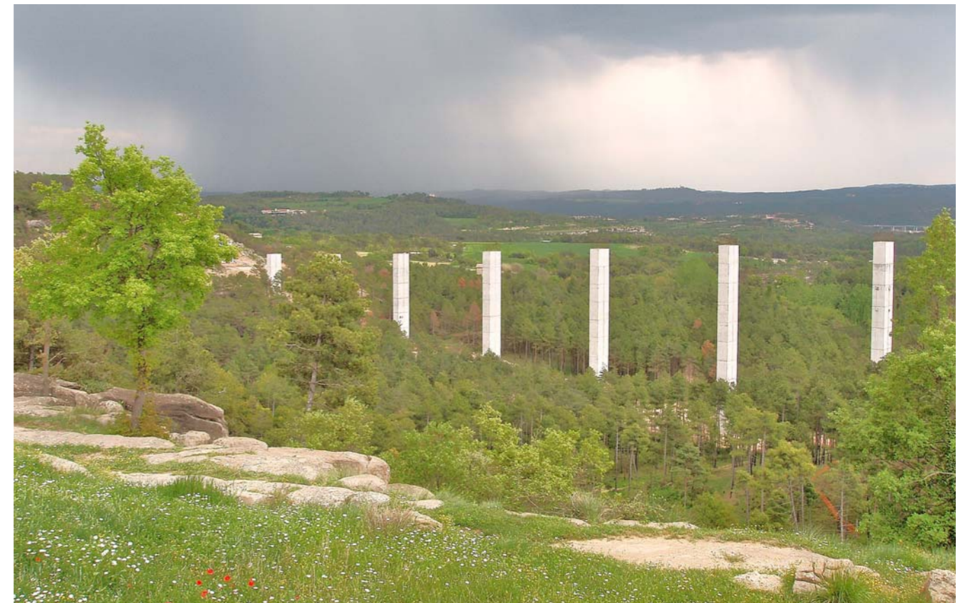
Figura 5.21: Les infraestructures viàries són especialment rellevants a les Comarques Centrals. Construcció d'un viaducte a Casserres. Replans del Berguedà.
