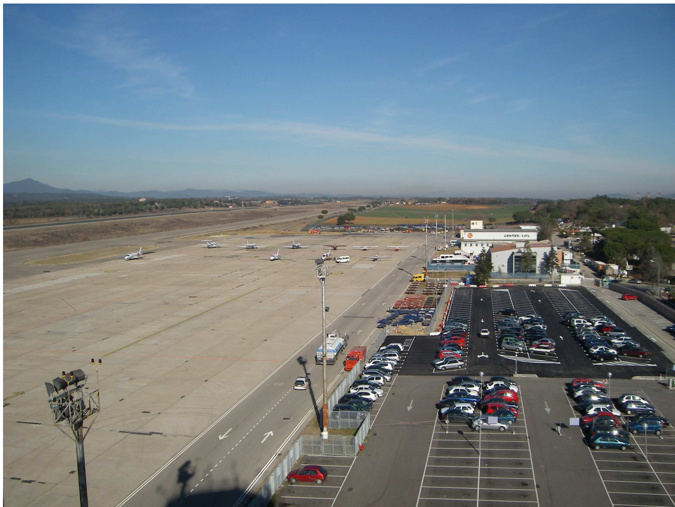
Figura 5.19: Instal·lacions de l'aeroport Girona-Costa Brava i el seu entorn.
