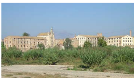
Figura 4.22. Vista de conjunt de la colònia industrial de Can Bros, a Martorell (Baix Llobregat). A diferència de la Colònia Güell, Can Bros ha patit un procés de degradació després de l'obsolescència de la fàbrica que en motivà l'origen.
