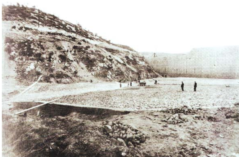
Figura 4.31. Les obres d'impermeabilització del pantà de Foix (Castellet i la Gornal, Alt Penedès), a finals de la dècada de 1920. L'embassament fou ideat per regar l'horta de Vilanova a l'inici del segle XX, tot i que el substrat càrstic motivà que s'hagués de replantejar el projecte durant el llarg procés constructiu que es prolongà per més de dues dècades. Font: Pomés i Barriendos (2002: 69).
