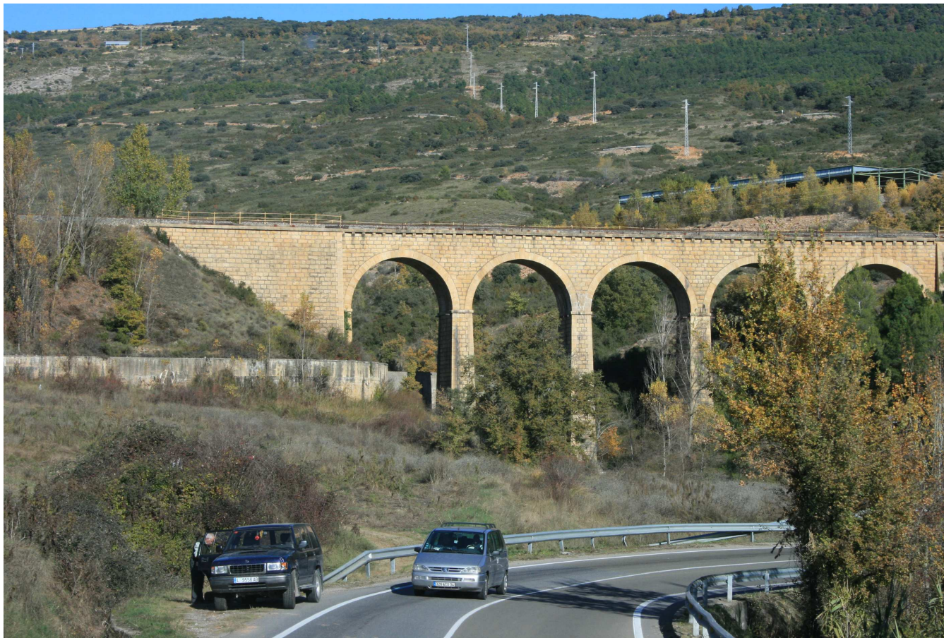
Figura 4.3. Les infraestructures lineals (carreteres, vies fèrries i línies elèctriques) formen part del paisatge actual i són fruit de l'evolució ocorreguda durant el segle XX
