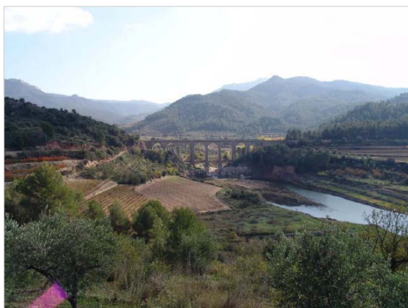
El viaducte del ferrocarril a Capçanes salva el torrent de Fontaubella ja a la cua del pantà dels Guiamets. Els conreus de vinya instal·lats en les terrasses fluvials i les feixes eslaonades a banda i banda del curs d'aigua
