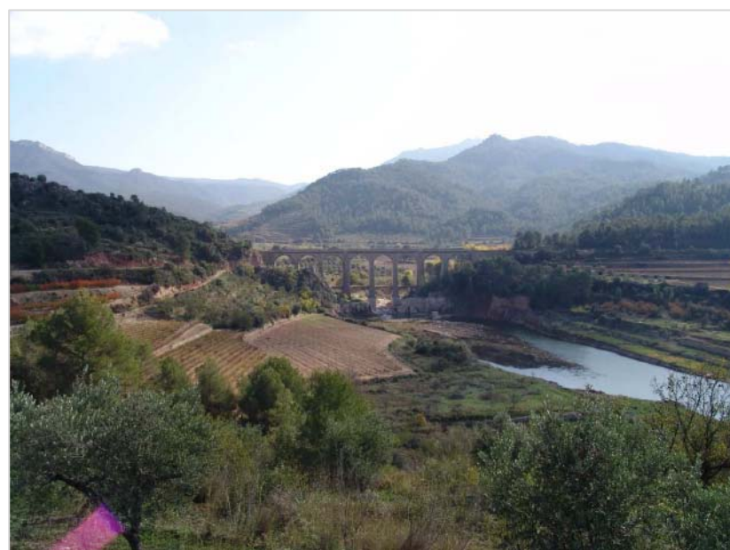
El viaducte del ferrocarril a Capçanes salva el torrent de Fontaubella ja a la cua del pantà dels Guiamets. Els conreus de vinya instal·lats en les terrasses fluvials i les feixes esclonades a banda i banda del curs d'aigua
